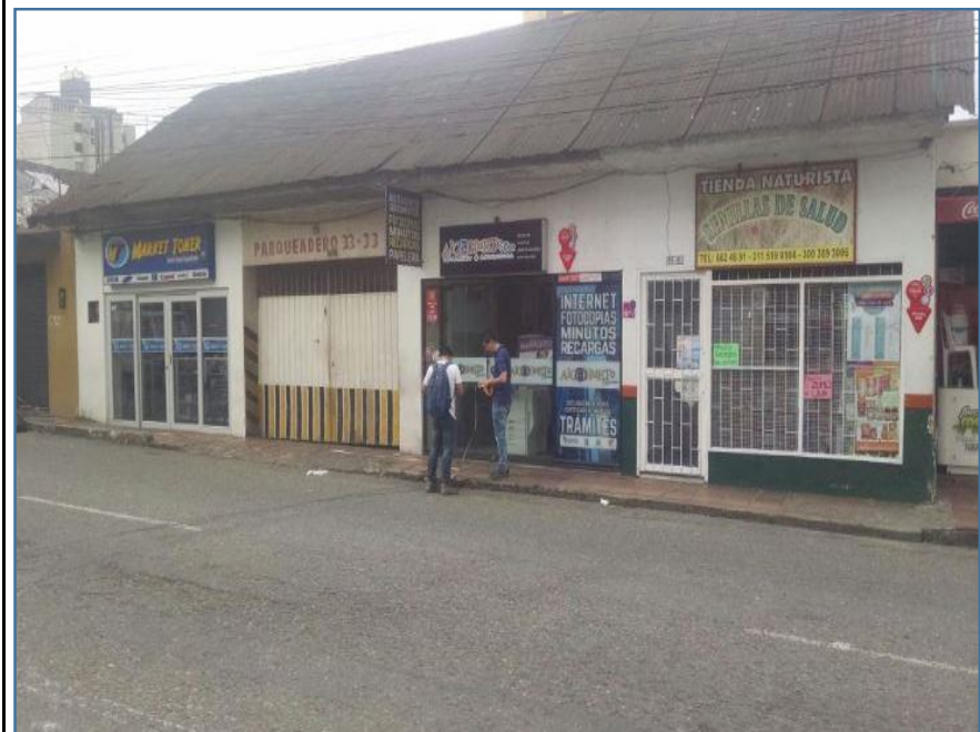
FACHADA DE LA CONSTRUCCION
