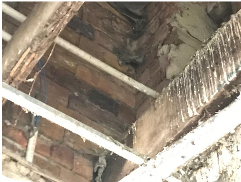
Figura 106. Dilatación Exploración dilataciones de módulo 3 hacia módulo 2
