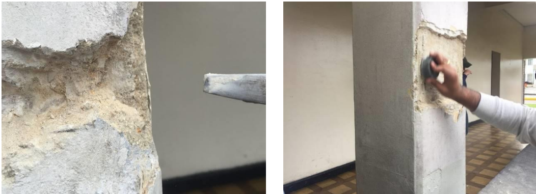
Figura 33. Preparación de la superficie mediante piedra de amolar y brocha
