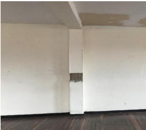
Figura 85. Machones salientes existentes en módulos a intervenir.
