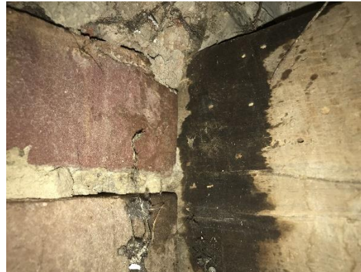
Figura 54. Apoyo del entrepiso de madera sobre la mampostería (protección contra humedad con aceite).
