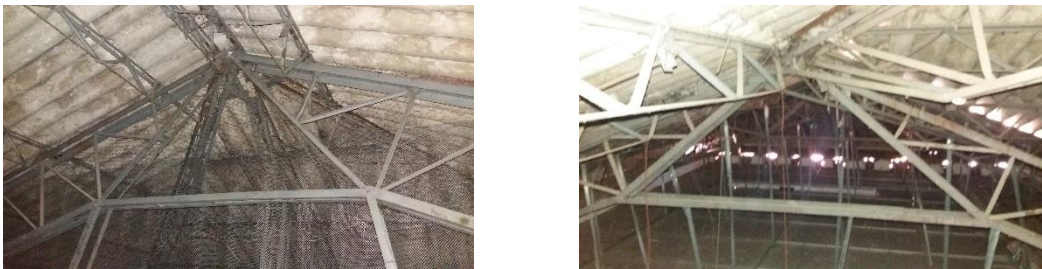
Figura 28. Detalle general de estructura de cubierta metálica
