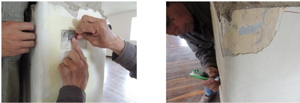
Figura 71. Elaboración de cala cromática en muros de mampostería.
