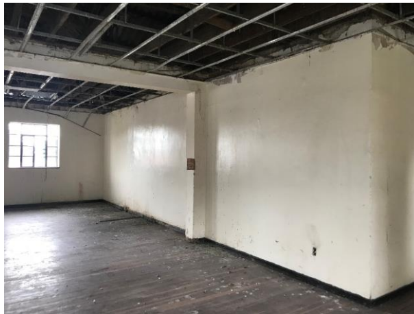
Figura 87. Pórtico existente, viga en concreto machón en mampostería.
