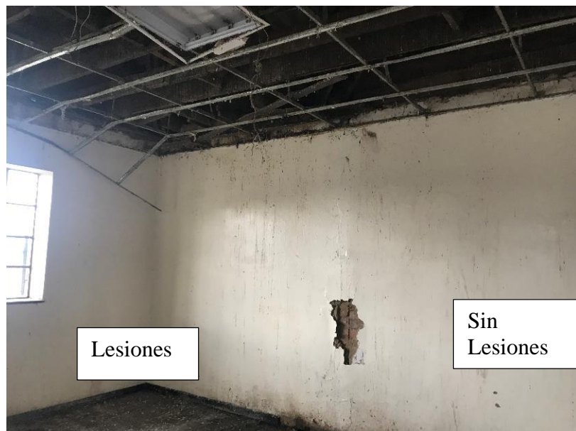
Figura 104. Exploración en pañete para descubrir dilatación.
