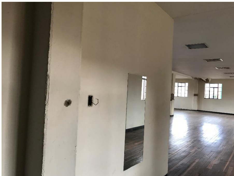
Figura 119. Machones internos existentes módulos 3 y 4
