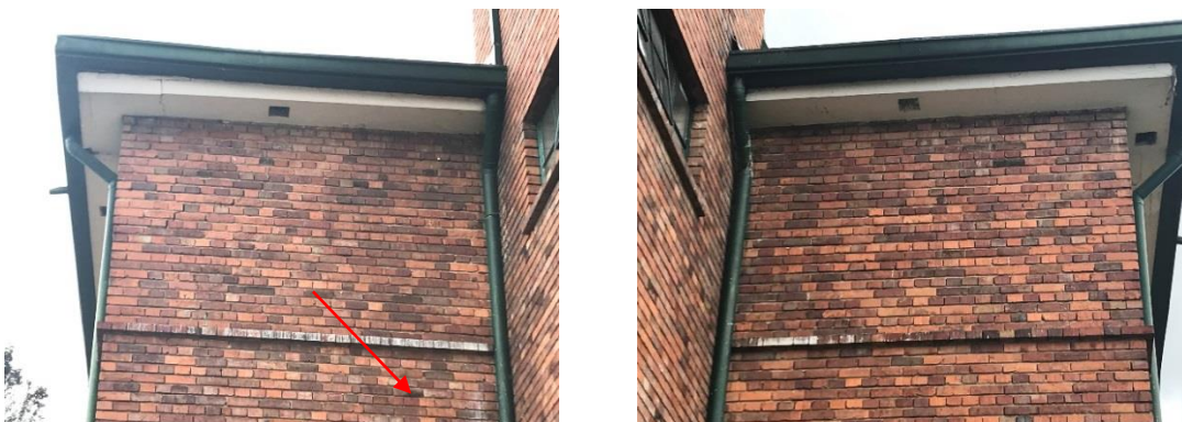
Figura 102. Módulos Lesiones diagonales de escalerilla en paños superiores.
