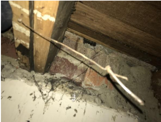
Figura 54. Apoyo del entrepiso de madera sobre la mampostería (protección contra humedad con aceite).
