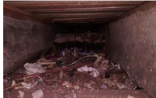
Figura 60. Estado de conservación de los elementos de madera del entrepiso.
