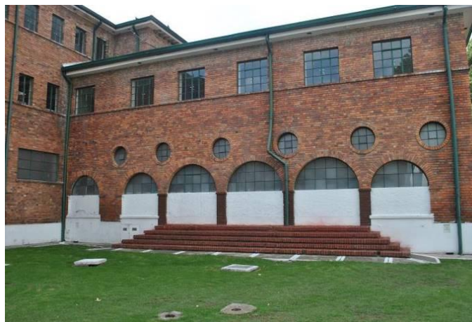
Figura 26. Elementos de mampostería predominantes, arcos en primer nivel
