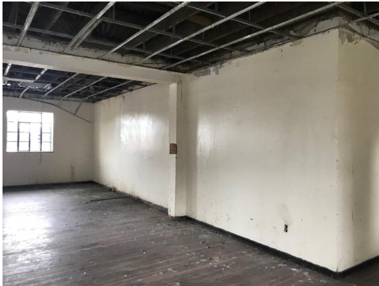
Figura 120. Pórtico existente viga en concreto machón en mampostería.
