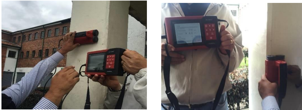
Figura 40. Detección de refuerzo en columna de concreto.
