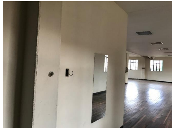
Figura 85. Machones salientes existentes en módulos a intervenir.
