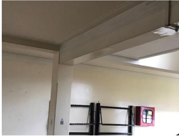
Figura 86. Columnas de concreto en pórticos del módulo 1.
