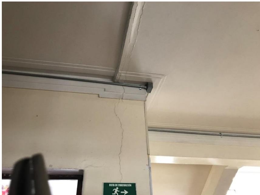
Figura 112. Detalle de dilatación entre módulo 1 y 2
