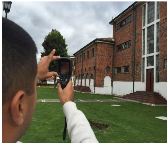
Figura 70. Contraste por termografía.
