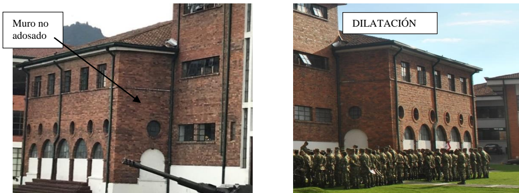
Figura 101. Módulos laterales contiguos construidos con posterioridad
