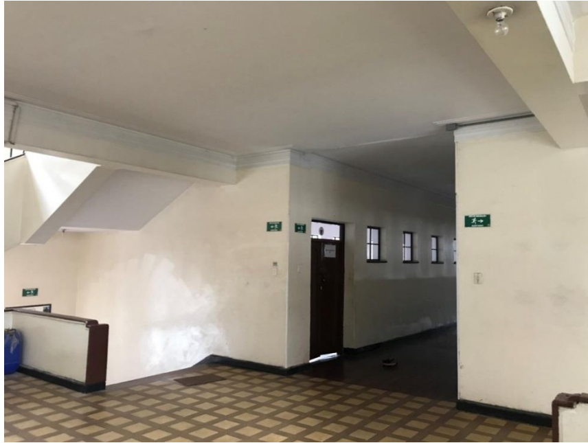
Figura 111. Dilatación entre módulo 1 y 2
