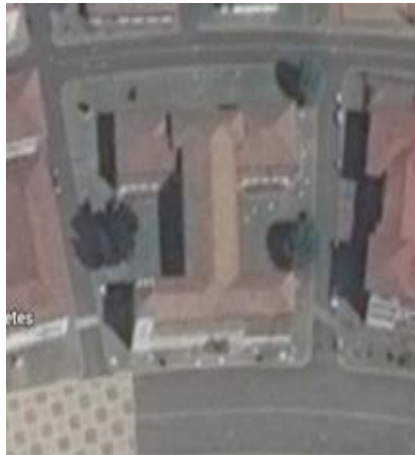
Figura 99. Vista aérea de la configuración actual del edificio.
