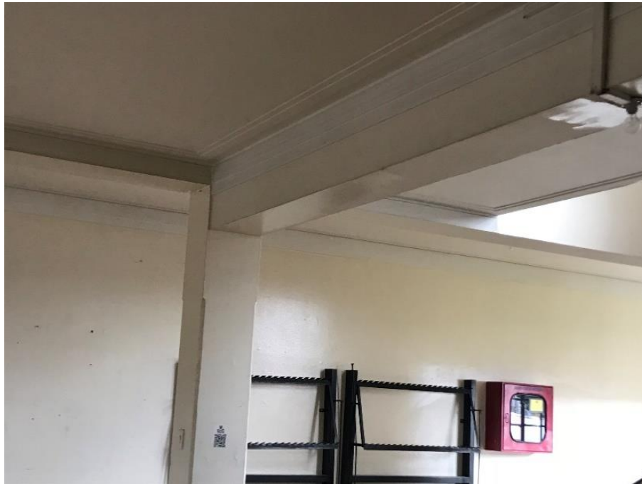
Figura 118. Columnas de concreto de pórticos Módulo 1 principal.
