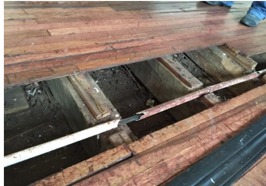
Figura 59. Levantamiento de elementos y apertura de ventanas de inspección.
