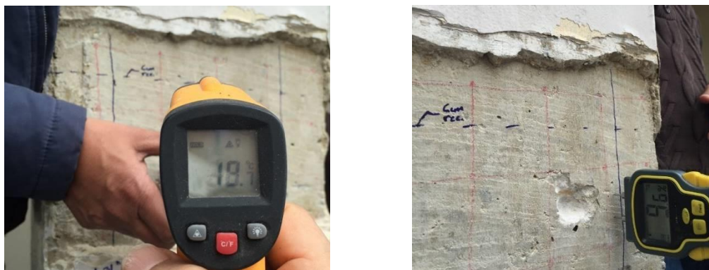
Figura 34. Medición de temperatura y humedad
