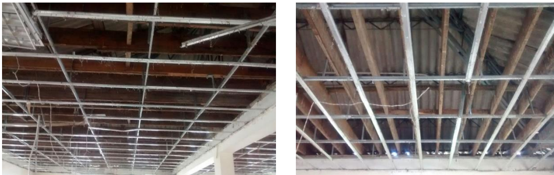
Figura 62. Apoyo del entramado de madera sobre pórtico en concreto para cubierta.
