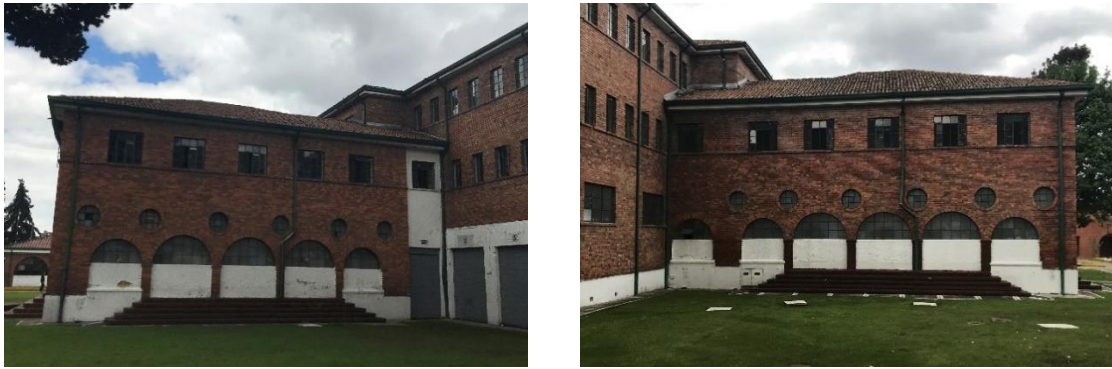
Figura 100. Vista Fachadas Internas módulos contiguos construidos posteriormente
