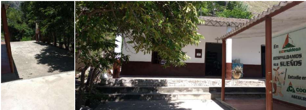
Figura 7. Patio y vestíbulo
