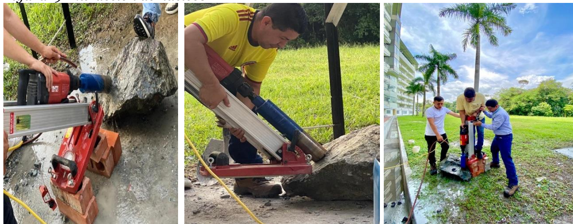
Figura 9-Extracción de núcleos
