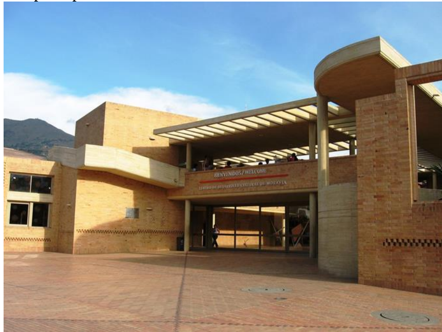
Figura 11. Acceso principal centro cultural de Moravia
