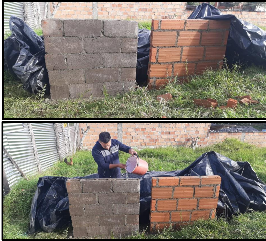
Imagen 38 Curado de la pega de mampostería de bloque ecológico y ladrillo tradicional
