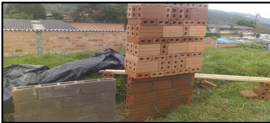
Imagen 39. Aplicación de cargas para determinar la compresión del murete de ladrillo de arcilla
