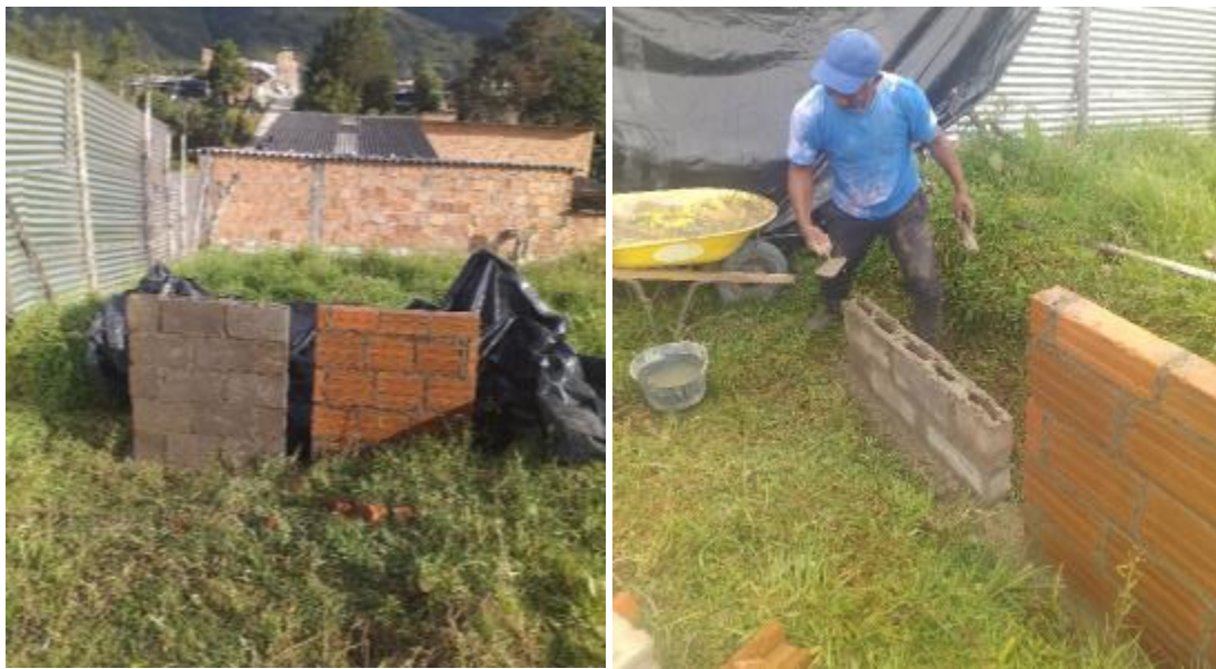
Imagen 37. Fabricación de los muretes con ladrillo tradicional de arcilla y bloques ecológicos para la prueba de campo de resistencia a la compresión.
