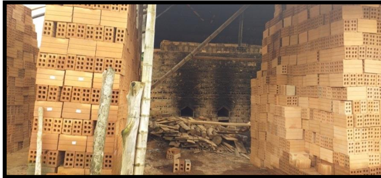
Imagen 11. Hornos de quema de ladrillo (contaminantes del aire con CO 2 ). Fuente esta investigación. 2019
