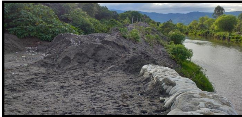
Imagen 8. Arenas finas acumuladas por des colmatación del sistema drenaje del valle de Sibundoy. Fuente esta investigación. 2019
