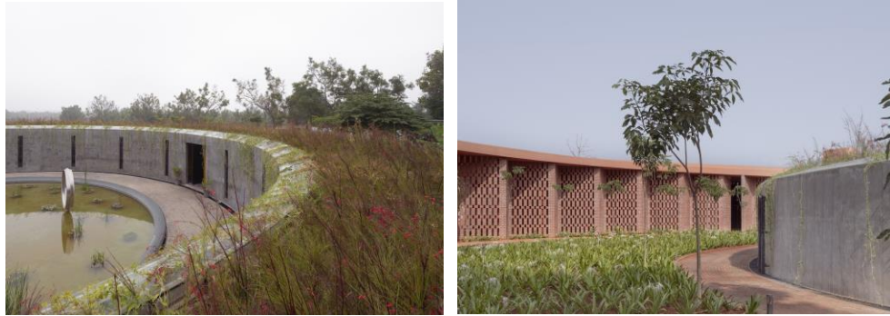
Figura 96. Vista hacia el acceso interior y la celosía posterior del centro memorial
