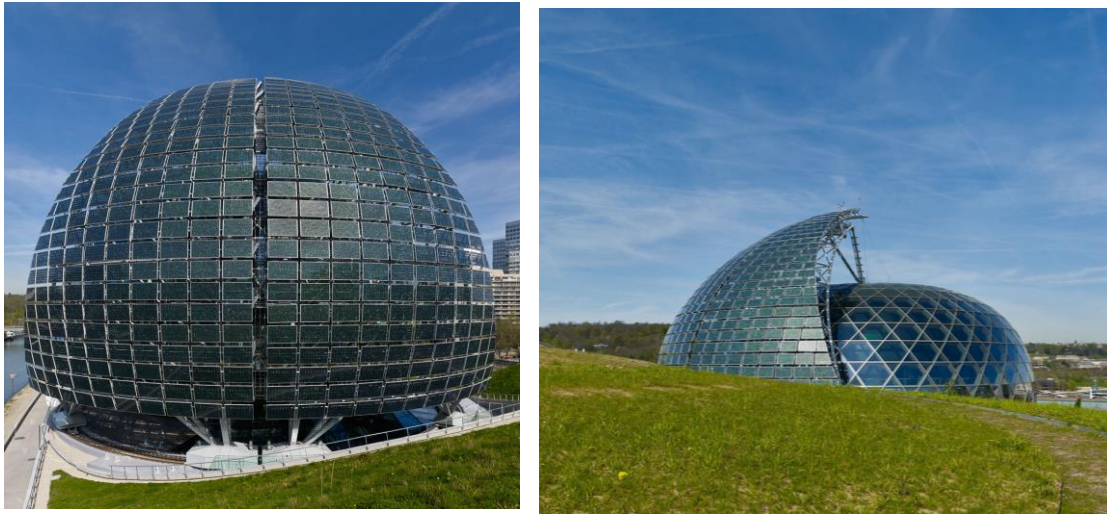
Figura 79. Vista hacia el sistema de energía limpia y estructura móvil
