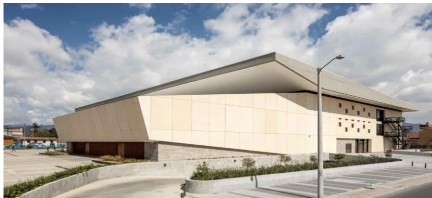
Figura 110. Fachada zona de parqueaderos
