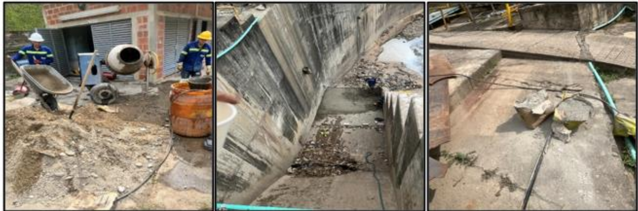
Figura 9. Fundición de excavaciones para rampas de compuerta de la planta La Cascada de la Electrificadora de Santander (ESSA)
