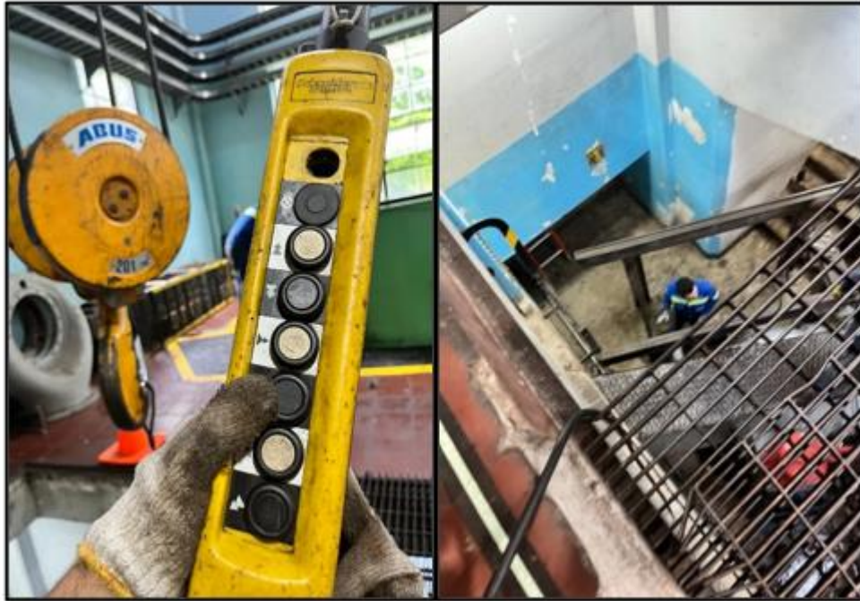
Figura 8. Supervisión de la empresa Electrificadora de Santander (ESSA).
