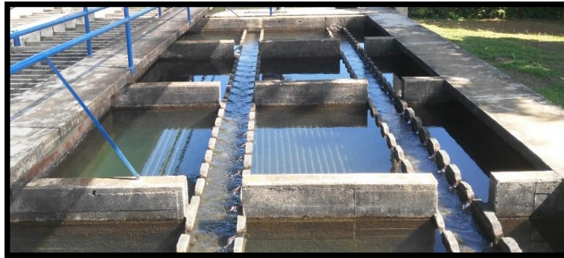
Figura 10: Sedimentador de alta tasa.
