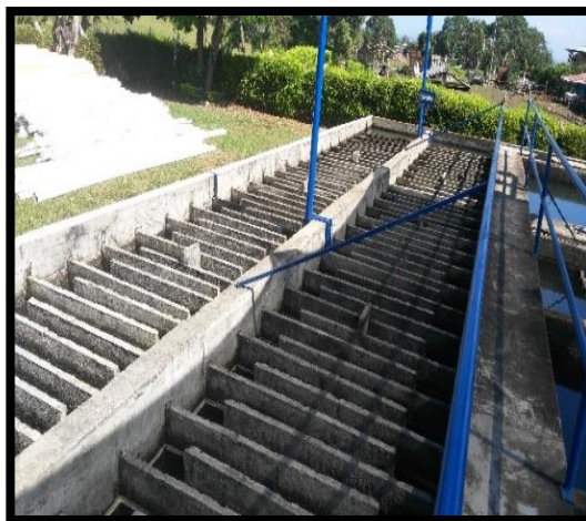
Figura 8: Floculadores de flujo horizontal.
