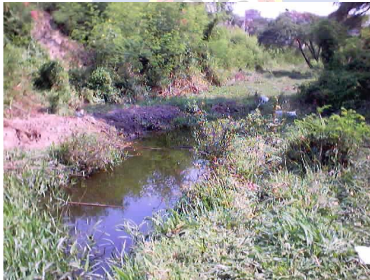
FOTO 5 Características del canal en el sector
