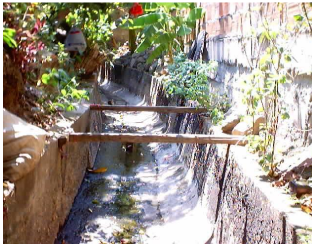
FOTO 2 Canal revestido (K0+046)
