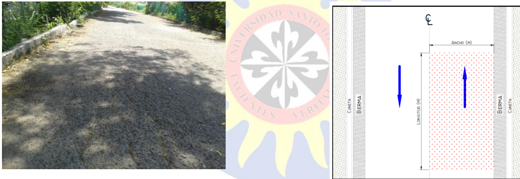
FOTO 13 Cabezas duras (CD unidad de medición m 2 )
