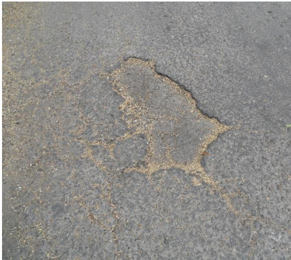
FOTO 10 Descascaramiento (DC, unidad de medida m2). Km 0+250
