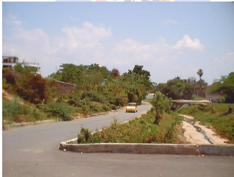
FOTO 4 Canal revestido (K0+335)
