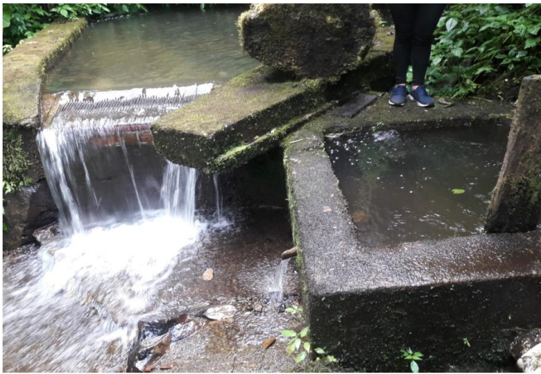
Ilustración 5. Bocatoma Acueducto Agua Santa ESP.
