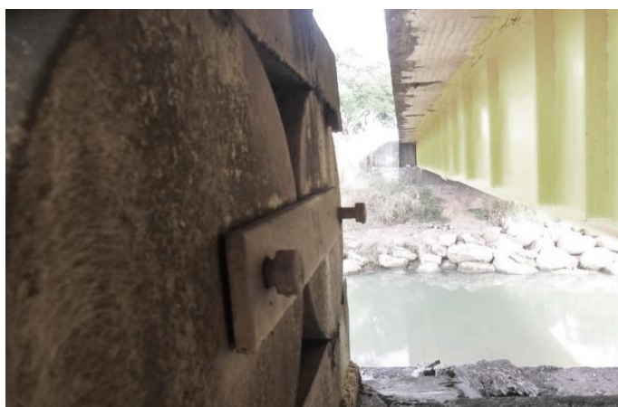
Figura 40. Evidencia de pernos a punto de ser expulsados
