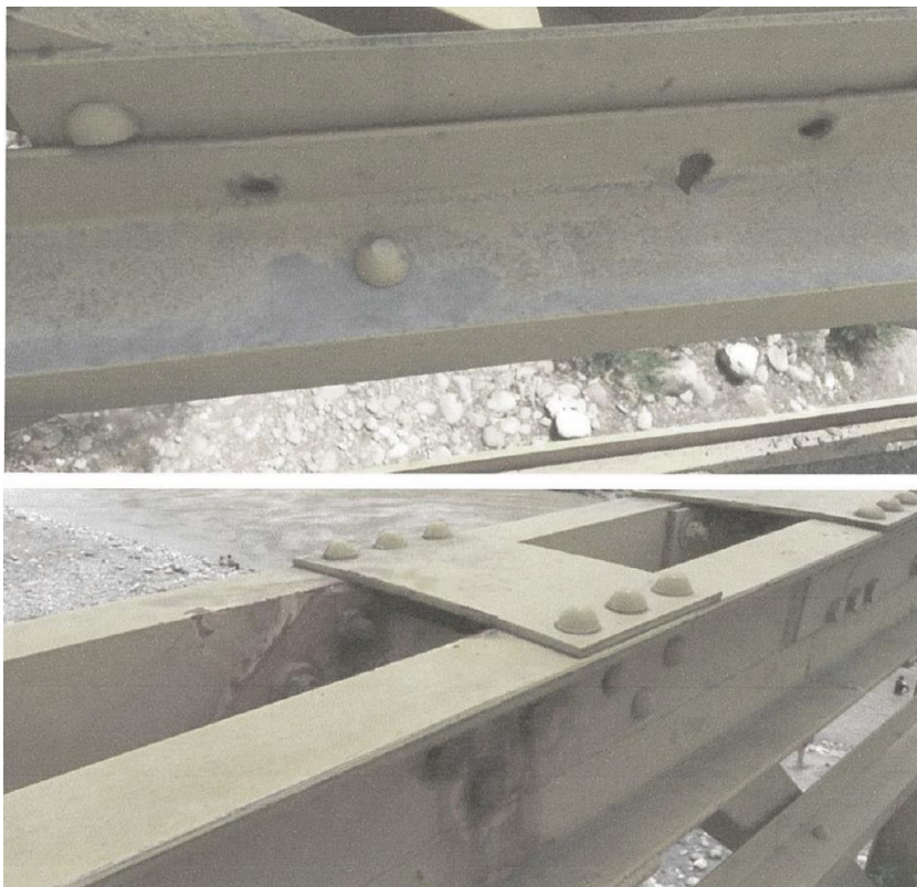
Figura 50. Remaches sin cabeza y reemplazo con pernos donde originalmente existían remaches.
