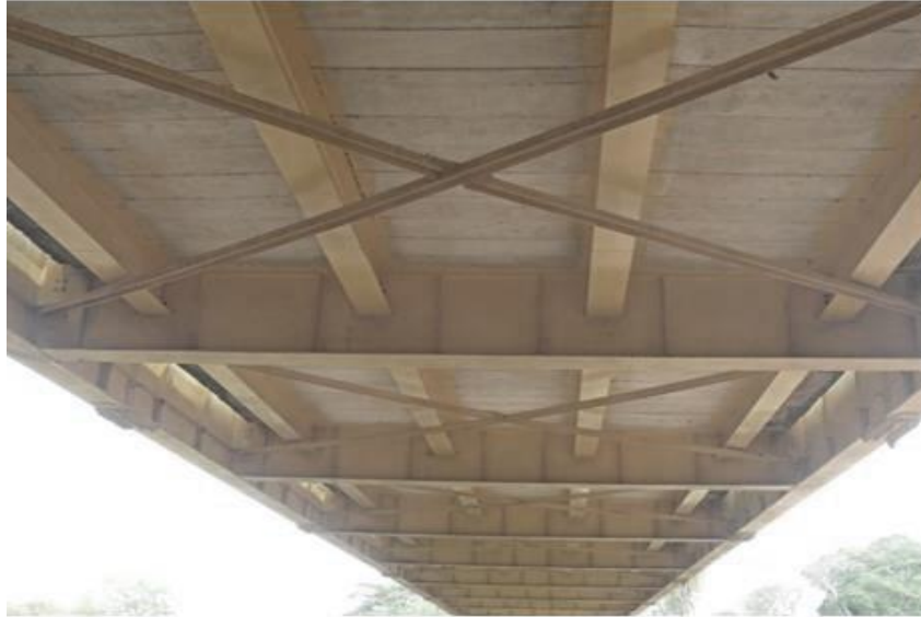
Figura 14. Vigas longitudinales
