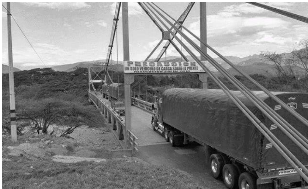
Figura 4. Restricción del tránsito a un sólo vehículo pesado sobre el puente
