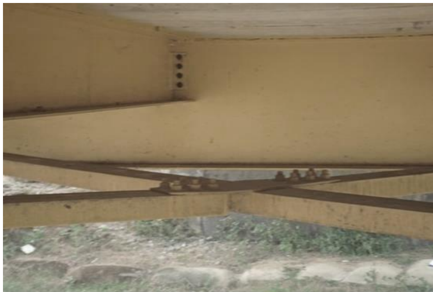
Figura 30. Riostras de vigas transversales
