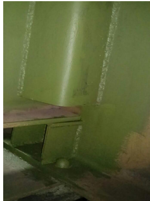
Figura 71. Reparación de unión de viga
