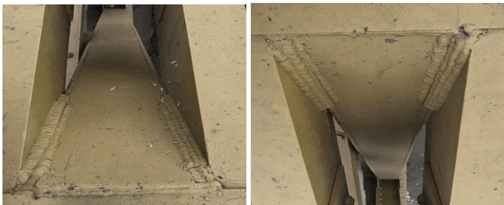
Figura 54. Refuerzo colocado diagonales
