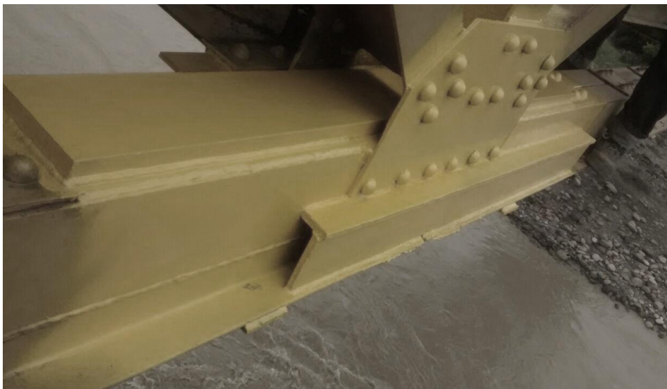
Figura 67. Reposición de cinta inferior de viga de rigidez
