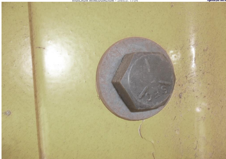
Figura 22. Tornillo grado 5 alta resistencia instalado
