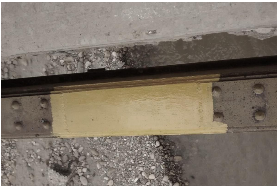
Figura 68. Reparación de cinta inferior de viga de rigidez
