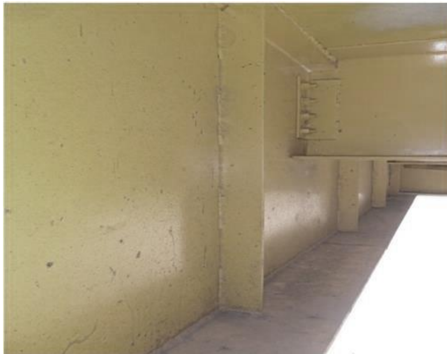
Figura 28. Vista viga transversal y atiesadores de refuerzo
