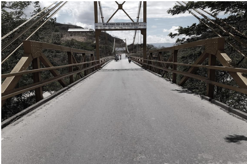
Figura 10. Buen estado del material (de la vía) que componen el elemento.
