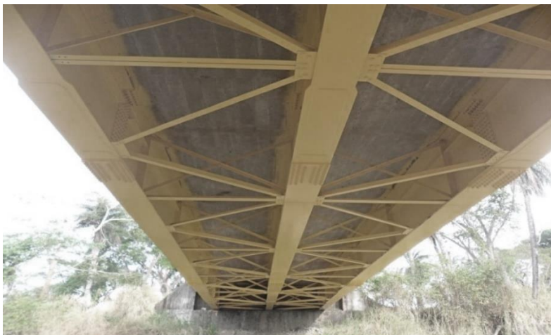
Figura 43. Buen estado del puente adicional
