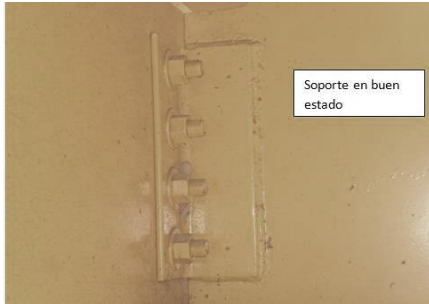
Figura 18. Soporte en buen estado
