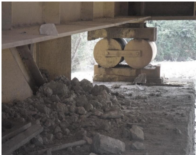
Figura 41. Áreas de trabajo de rodadura con escombros
