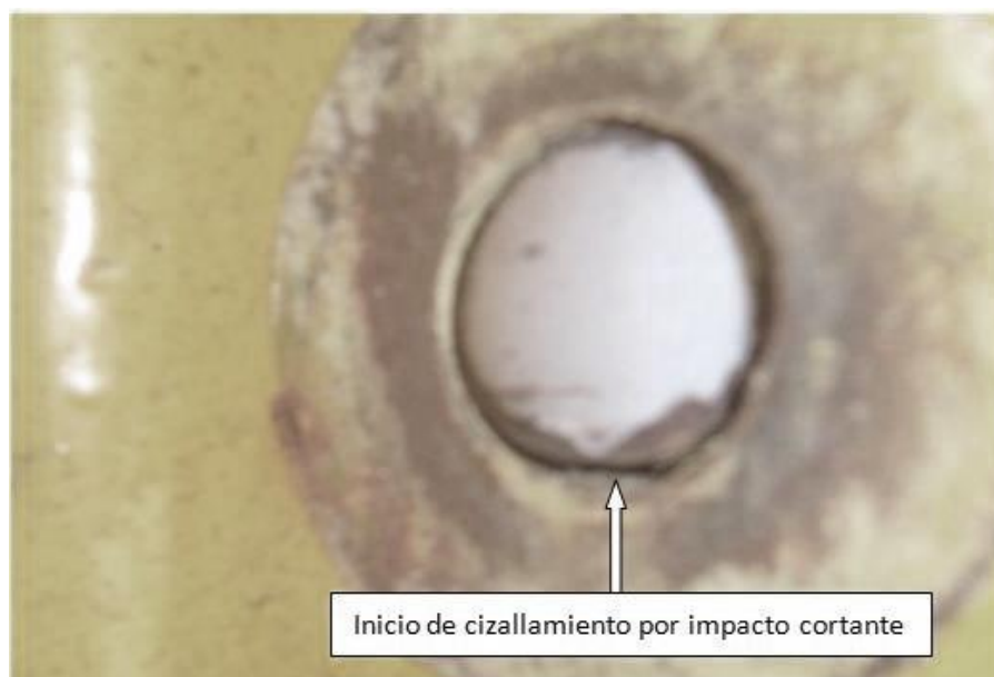
Figura 23. Evidencia del punto de fatiga parte inferior del diámetro del tornillo donde se inician el momento de cizallamiento
