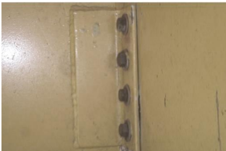
Figura 21. Evidencia de cambio de pernos
