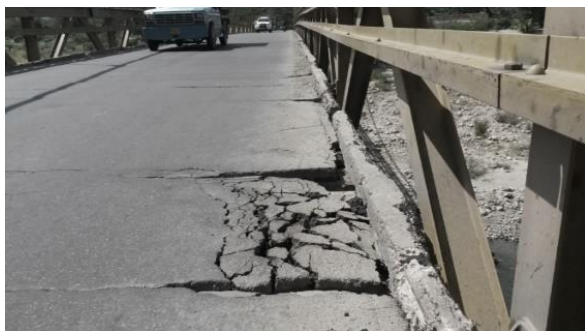
Figura 45. Descascaramiento
