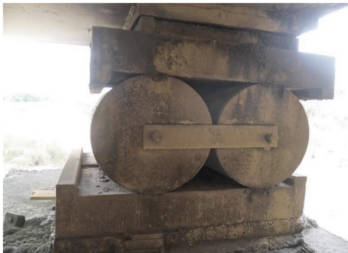
Figura 39. Apoyo punto móvil en pilas
