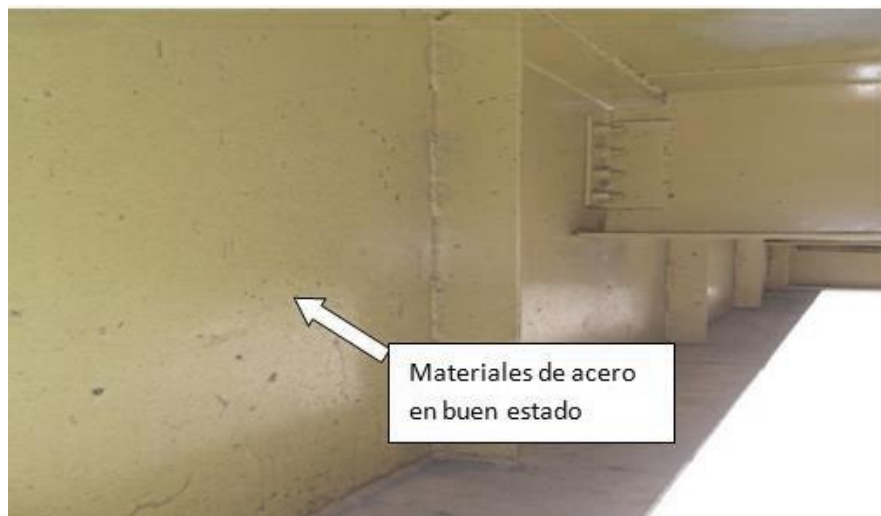
Figura 11. Buen estado del material (acero) que componen el elemento.
