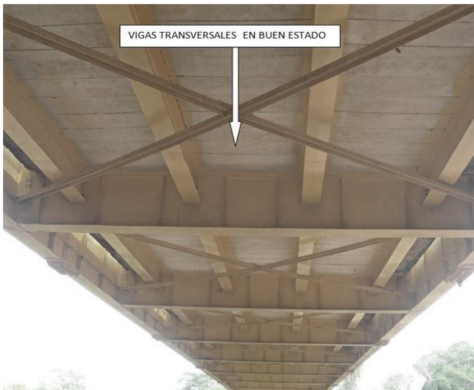
Figura 26. Viga transversal
