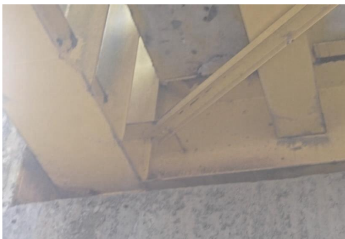
Figura 42. Puntos fijos de pilas
