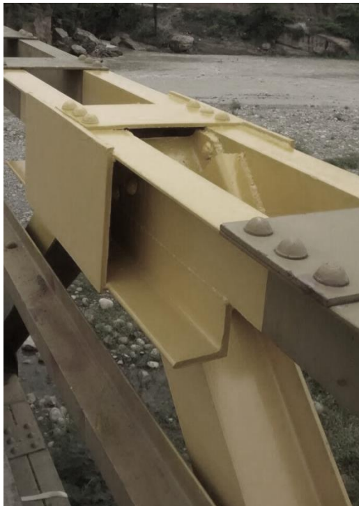
Figura 72. Reparación de primera diagonal en viga de rigidez
