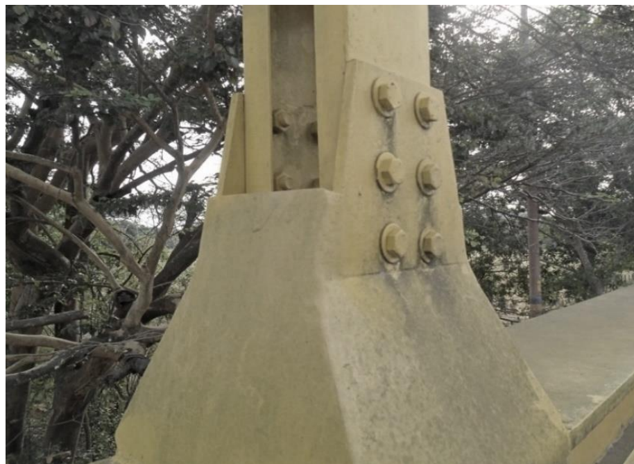
Figura 36.. Anclaje del pendolón a la viga de rigidez
