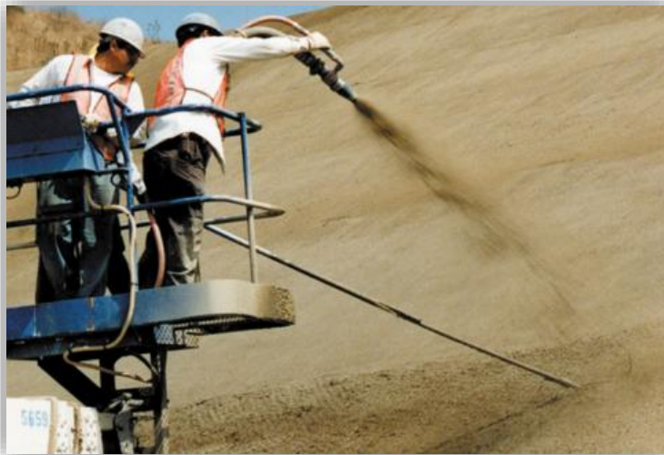
Ilustración 19. Lanzado de Concreto
