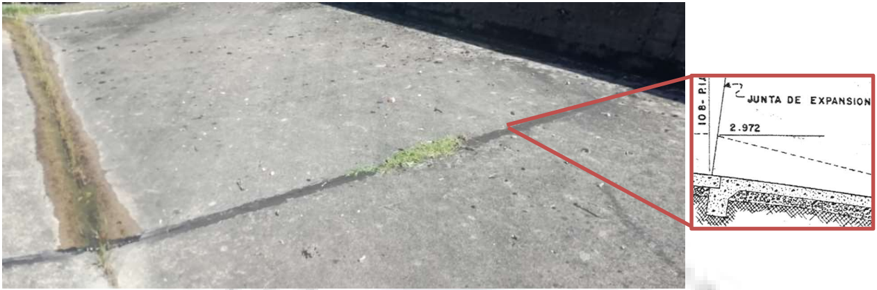
Fotografía. 82. Vista general junta transversal. Fuente: Consorcio Embalses CAR, 2020.
