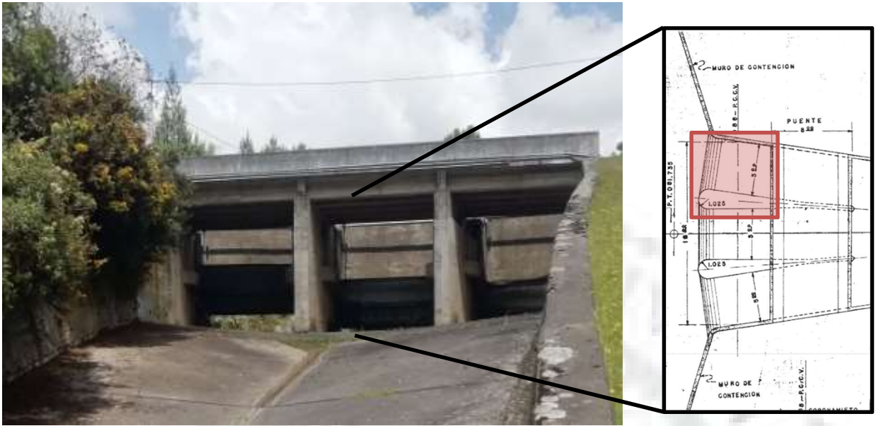
Fotografía. 80. Vista general compuertas (Aguas arriba). Fuente: Consorcio Embalses CAR, 2020.
