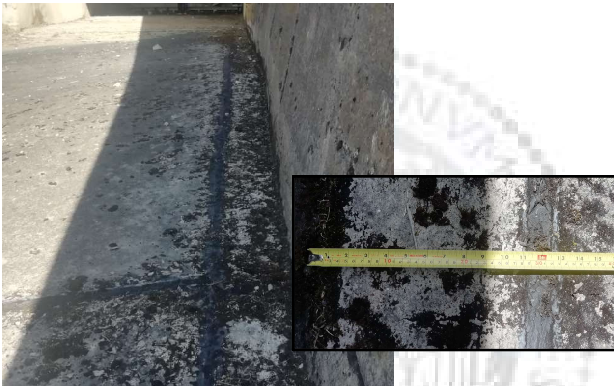
Fotografía. 84. Vista general junta longitudinal lateral.
