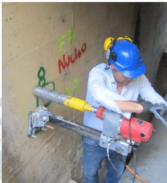
Fotografía. 101. Extracción núcleo en muro margen derecha canal de descarga. Fuente: Consorcio Embalses CAR, 2020.
