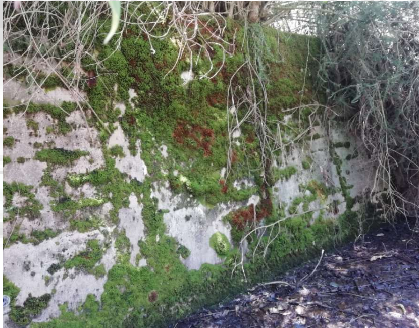
Fotografía. 91. Presencia y afloramiento de musgo sobre el muro lateral del canal. Fuente: Consorcio Embalses CAR, 2020.
