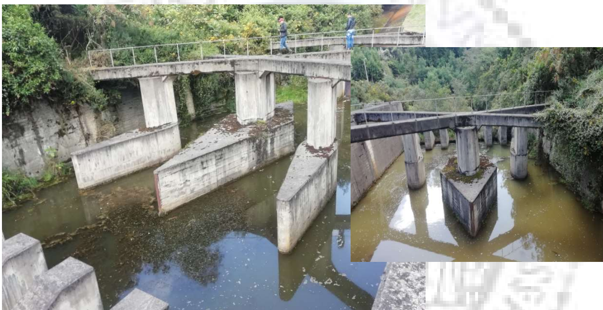
Fotografía. 93. Tanque de amortiguación, disipación y entrega del flujo. Fuente: Consorcio Embalses CAR, 2020.
