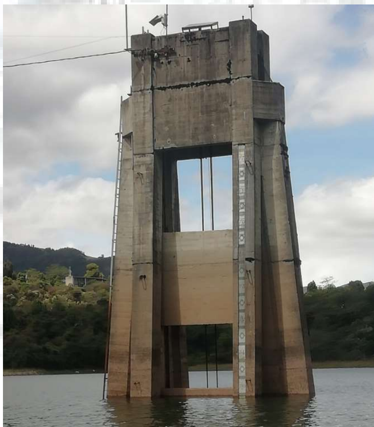
Fotografía. 70. Alzado general Torre de toma. Fuente: Consorcio Embalses CAR, 2020.
