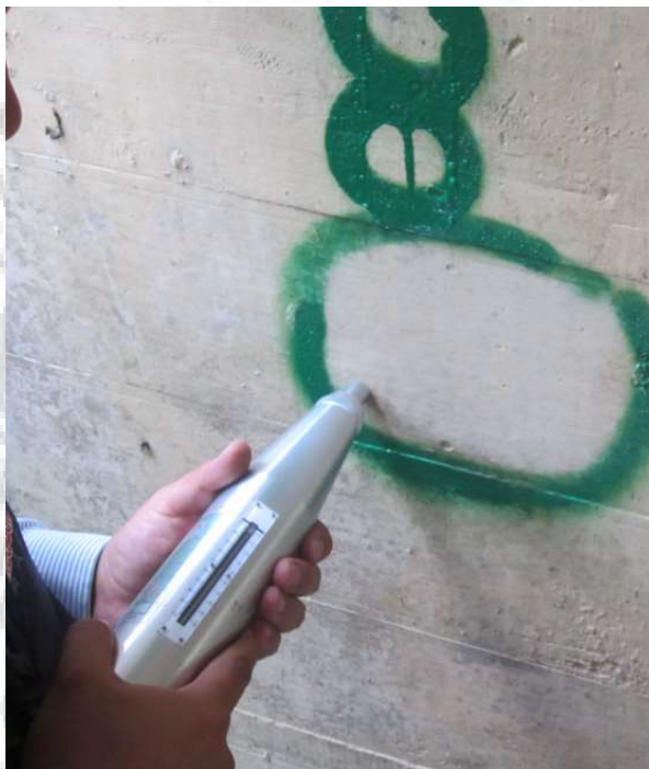
Fotografía. 100. Esclerometría en muro margen derecha canal de descarga. Fuente: Consorcio Embalses CAR, 2020.
