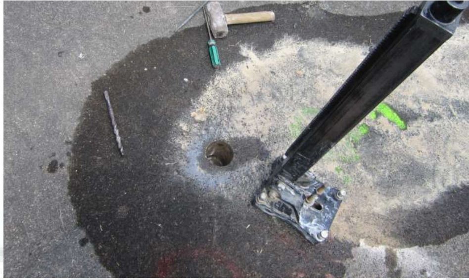
Fotografía. 97. Extracción núcleo en losa de fondo vertedero de excesos. Fuente: Consorcio Embalses CAR, 2020.
