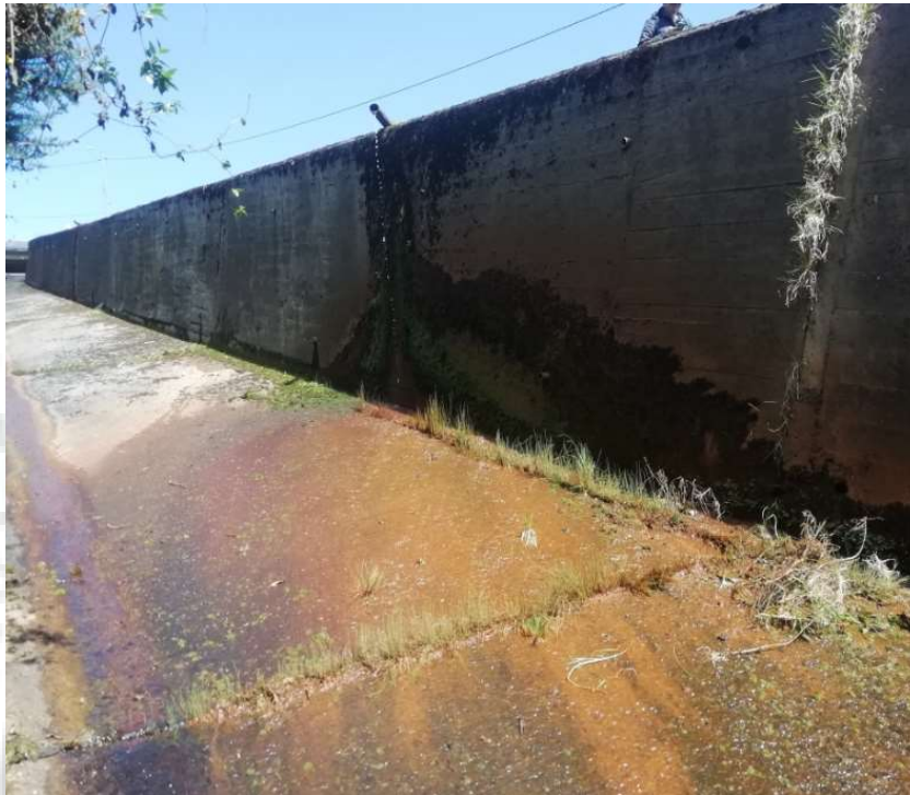
Fotografía. 87. Afloramiento de vegetación a través de la junta. Fuente: Consorcio Embalses CAR, 2020.
