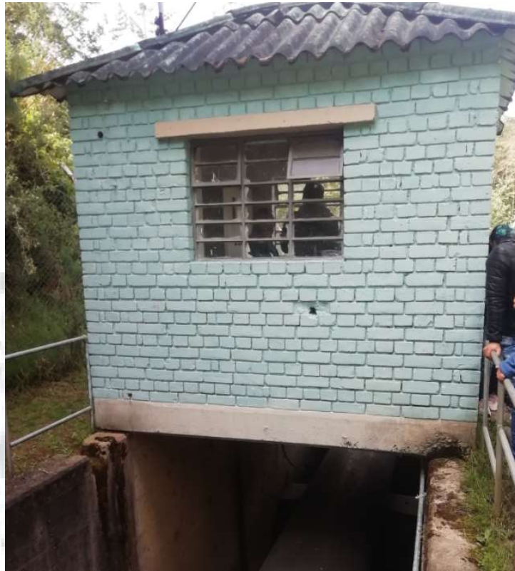
Fotografía. 78. Estado actual de la caseta de control. Fuente: Consorcio Embalses CAR, 2020.
