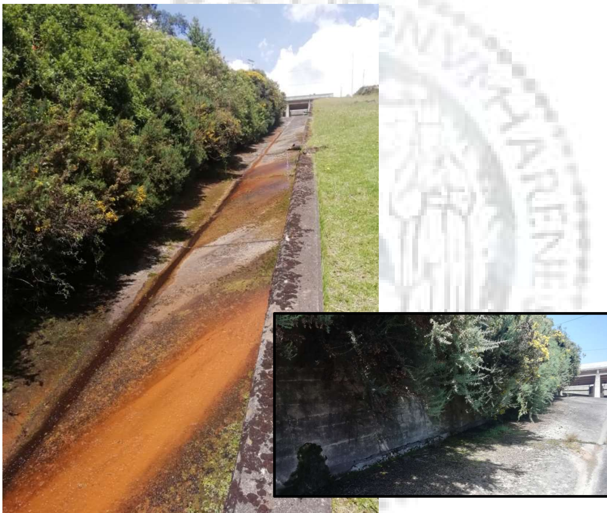
Fotografía. 92. Presencia de vegetación excesiva en el margen derecho del canal. Fuente: Consorcio Embalses CAR, 2020.
