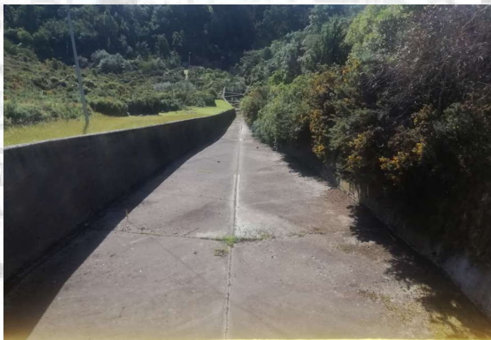
Fotografía. 79. Vista longitudinal del vertedero de excesos (Aguas arriba).
