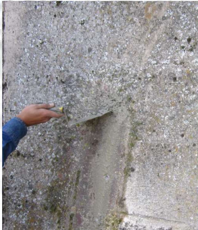
Fotografía. 98. Reparación típica de los núcleos extraídos. Fuente: Consorcio Embalses CAR, 2020.
