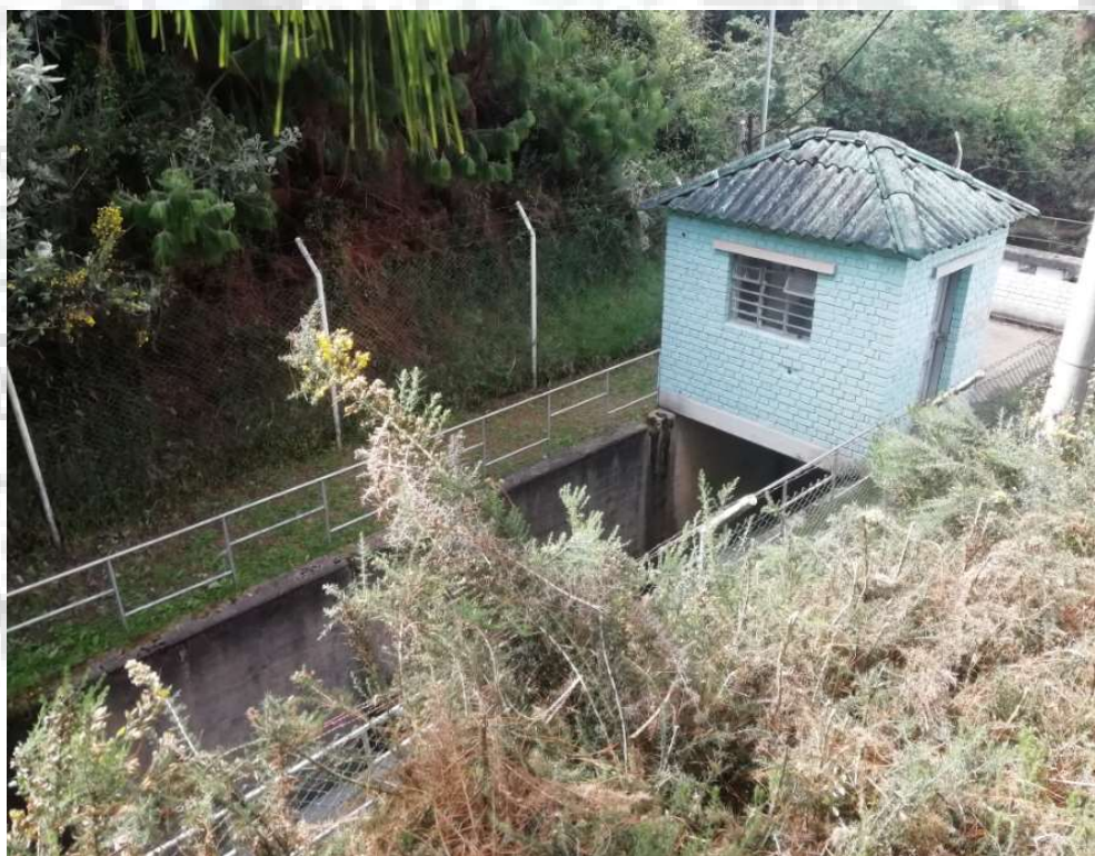
Fotografía. 74. Vista general canal de descarga y válvula.
