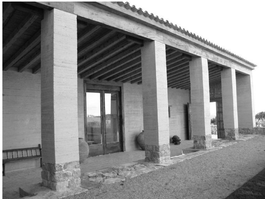
Figura 20. Muros Terminados en Tapia. Adaptado de Holguín, Camilo. (21 enero de 2016).
