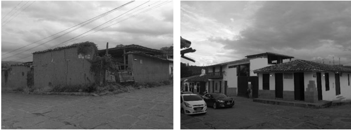
Figura 3. Izquierda, una vivienda en Tapia pisada a punto de caer. Derecha, nuevas construcciones que dejan de lado esta técnica.
