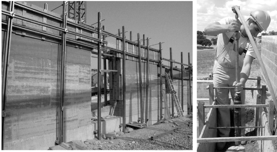
Figura 19. Construcción Muro de Tapia, Algunas reflexiones sobre arquitectura vernácula.
