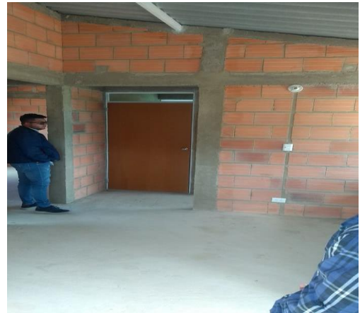
Imagen 45. Muro de culata y viga cinta
