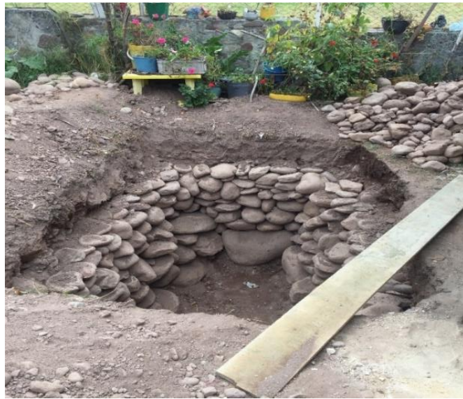
Imagen 51. Recubrimiento pozo séptico.
