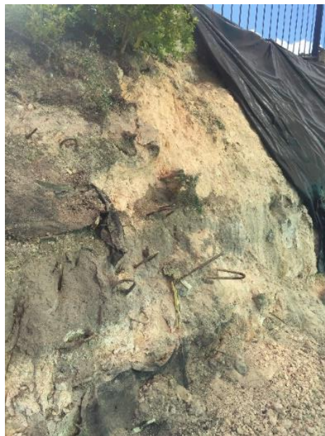
Imagen 61. Talud C.R. Avatar
