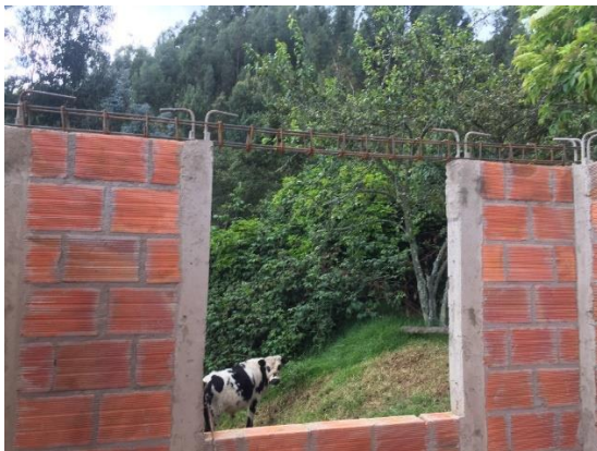
Imagen 39. Armado estructura viga de sobremuro.
