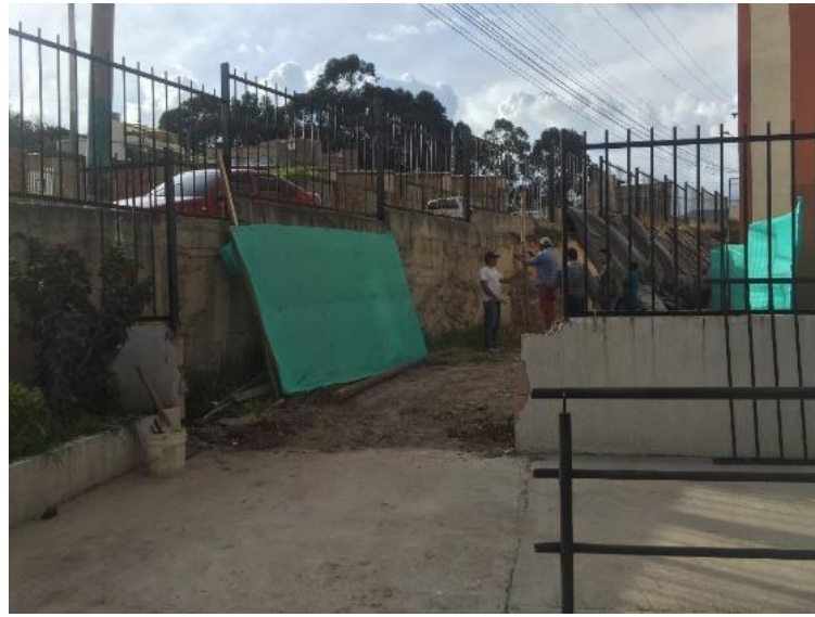
Imagen 73. Inicio de obras talud
