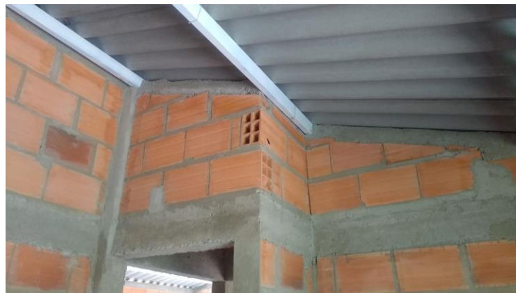
Imagen 46. Muro de culata y viga cinta
