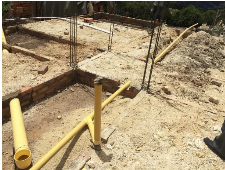
Imagen 13. Base compactada y paso de redes hidrosanitarias
