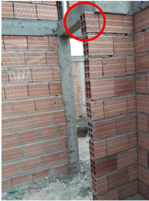
Imagen 36. Muro por fuera de la confinación
