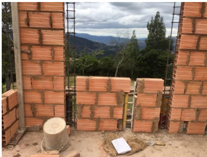
Imagen 34. Muro en mampostería.
