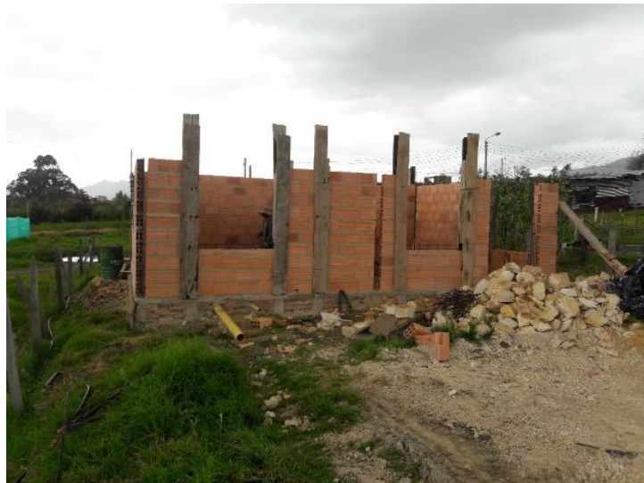
Imagen 37. Encofrado de columnas
