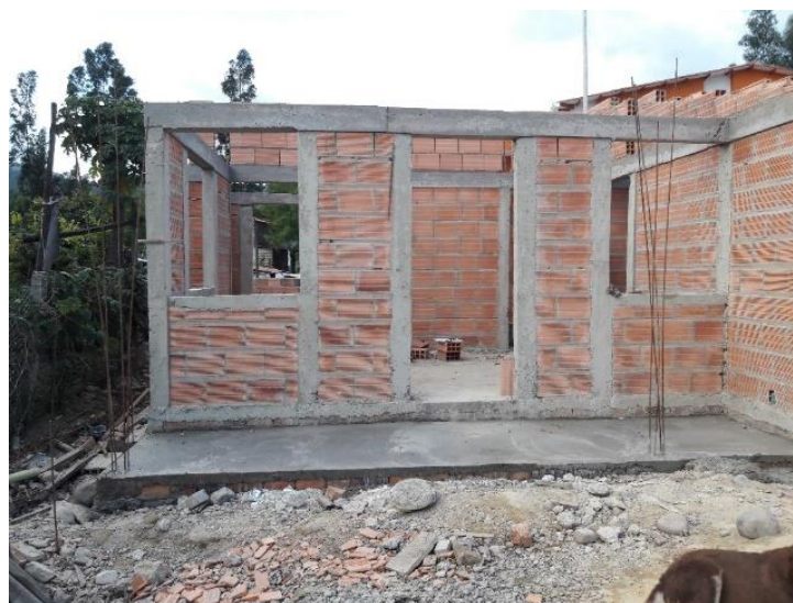
Imagen 43. Viga de Sobremuro.
