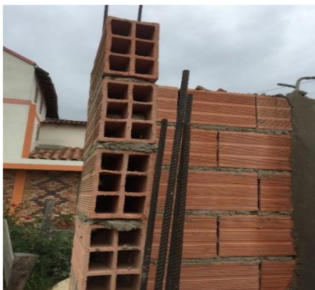
Imagen 35. Muro desalineado
