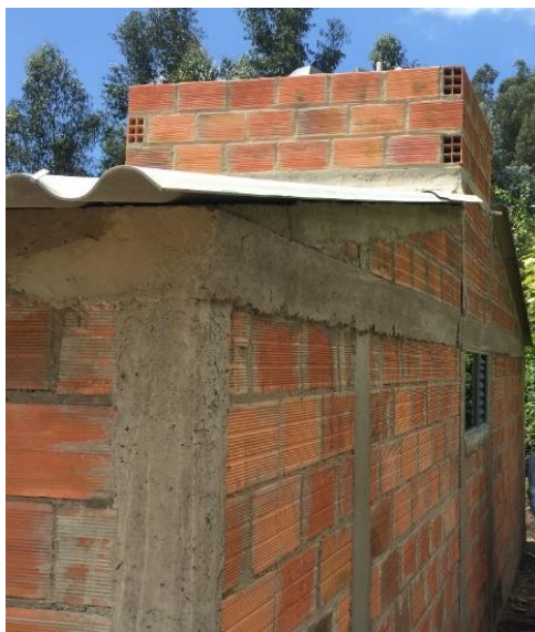
Imagen 25. Placa de tanques
