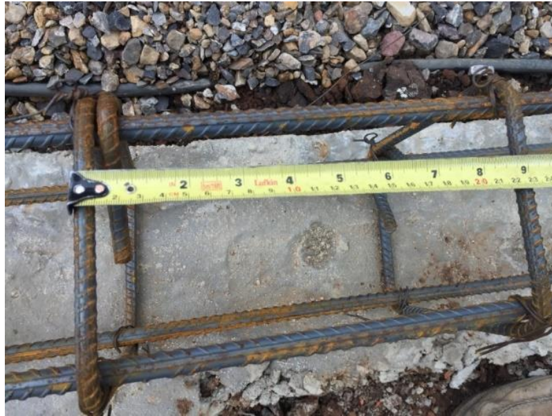
Imagen 31. Separación de flejes
