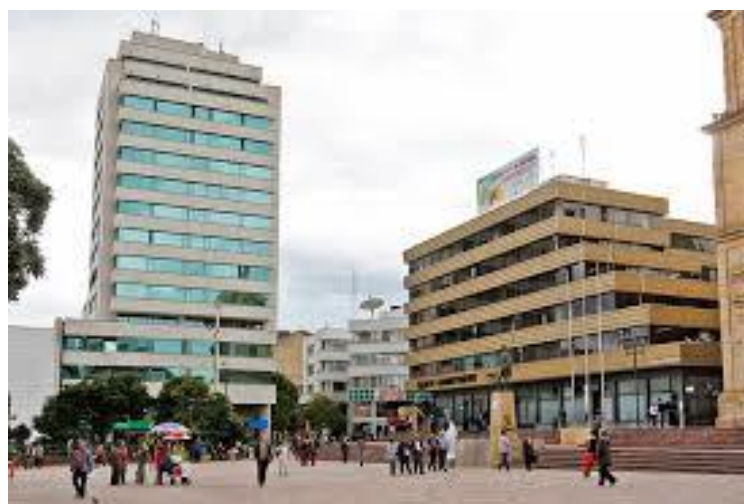
Imagen 1. Fotografía edificio Administrativo (Autor, 2019)
