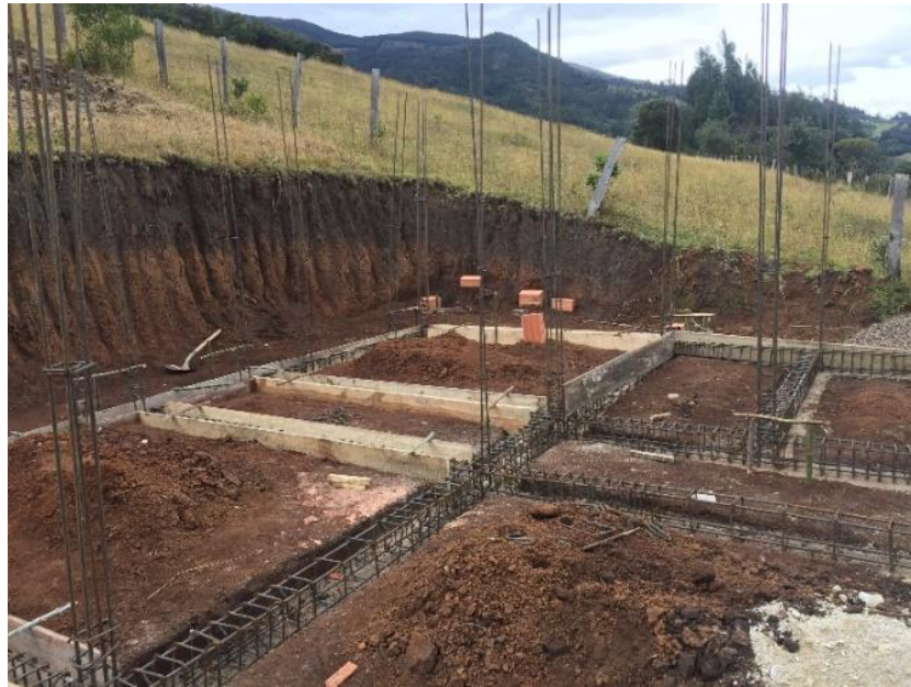
Imagen 11. Armado de la estructura de la viga de cimentación
