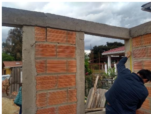
Imagen 41. Viga sobremuro
