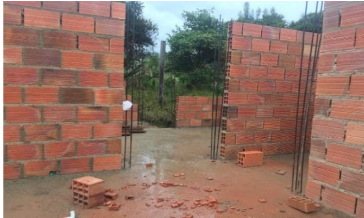
Imagen 15. Muros en mampostería
