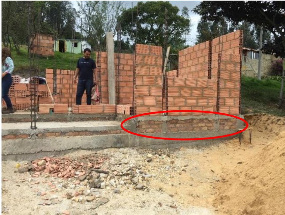
Imagen 12. Sobrecimiento en ladrillo común
