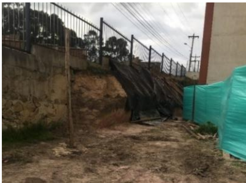
Imagen 72. Inicio de obras talud.
