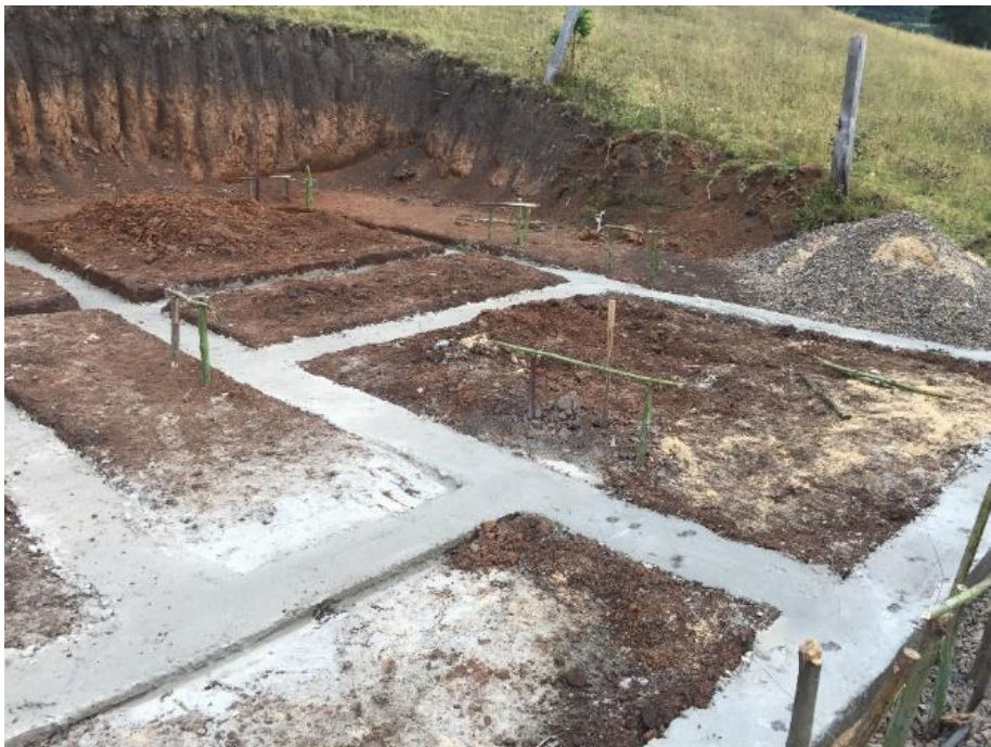
Imagen 10. Excavación y colocación del solado.
