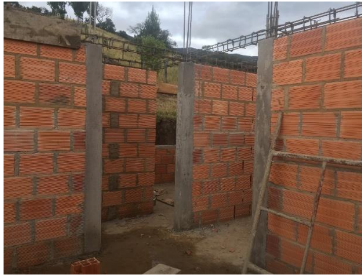
Imagen 19. Empalme de columnas.
