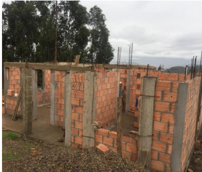
Imagen 17. Proceso constructivo de columnas.
