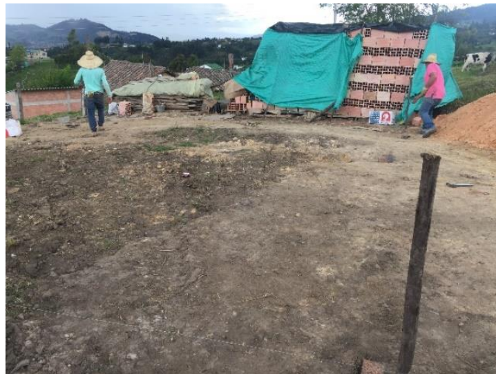
Imagen 7. Localización y Replanteo
