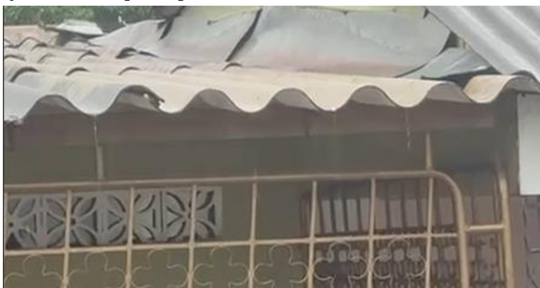
Figura 5 Área del tejado con limpieza previa
