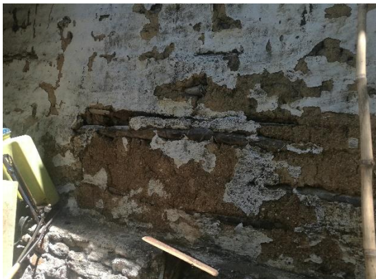
Figura 18; Muro Norte zona 1, cara externa.
