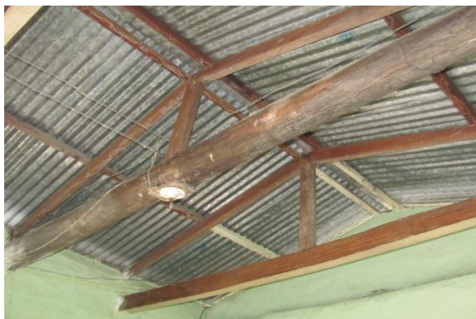
Figura 6; Estructura y cubierta existente (zona 1).
