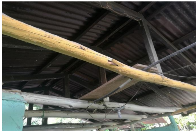
Figura 7; Estructura y cubierta existente (zona 2).
