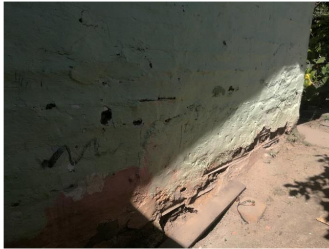
Figura 13; Muro sur de la zona 2, cara externa.
