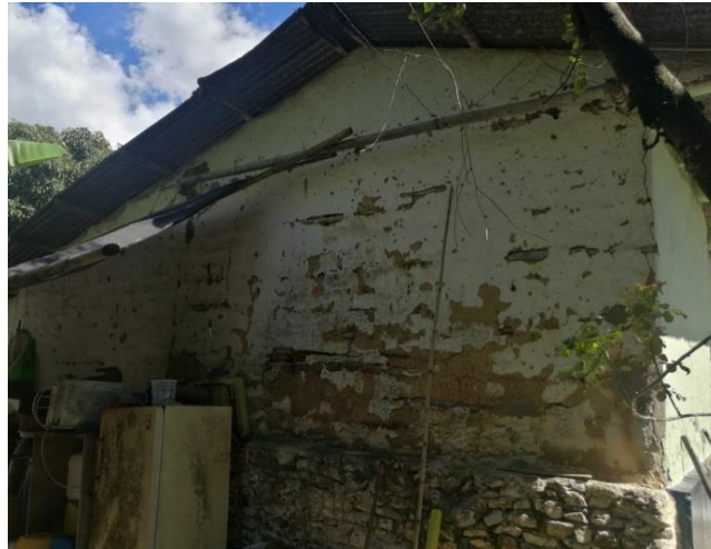
Figura 10; Muro costado norte, cara externa.
