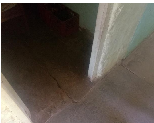
Figura 22; Foto: estado real del piso zona 1.
