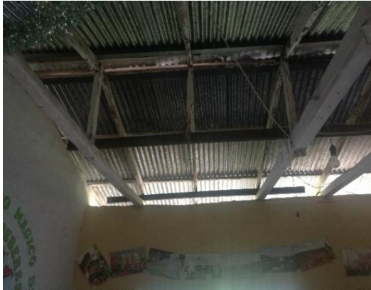
Figura 23; Red eléctrica existente.
