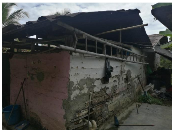
Figura 12; Muro Norte de la zona 2, cara externa.
