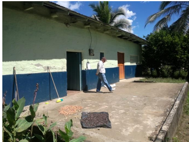
Figura 9; Muro de Fachada principal.
