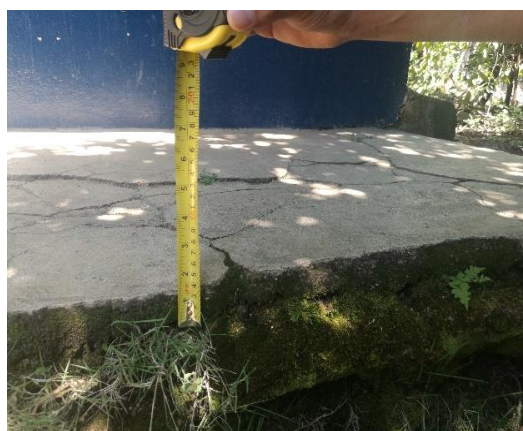
Figura 213; Foto: estado real del piso zona 2.
