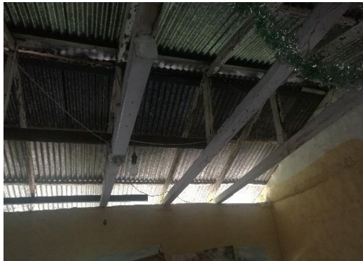
Figura 17; Estructura de cubierta.
