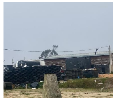
Figura 2. Muros con llantas usadas
