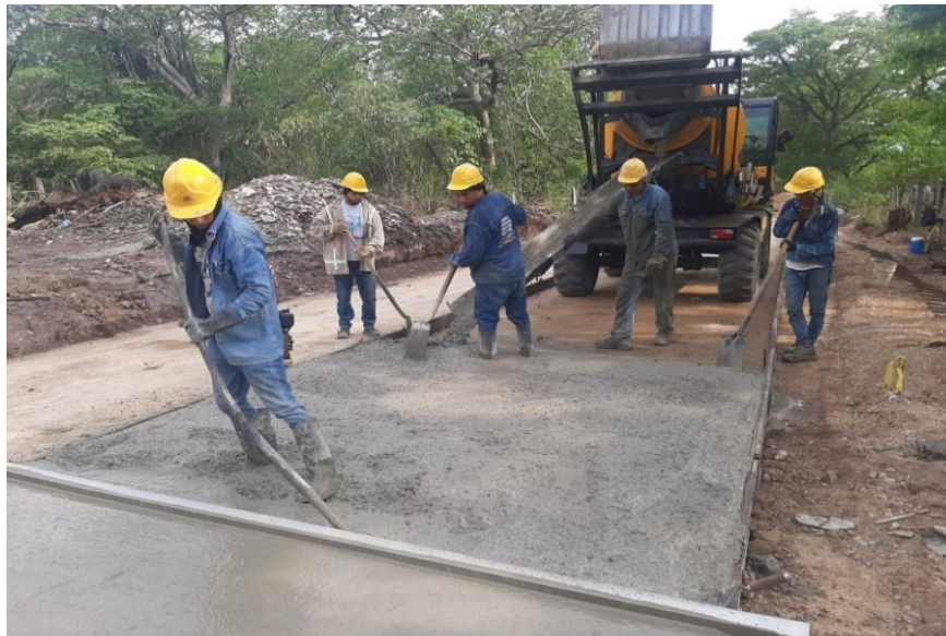
. Figura 18. La Paz Cesar (Vaciado del concreto)
