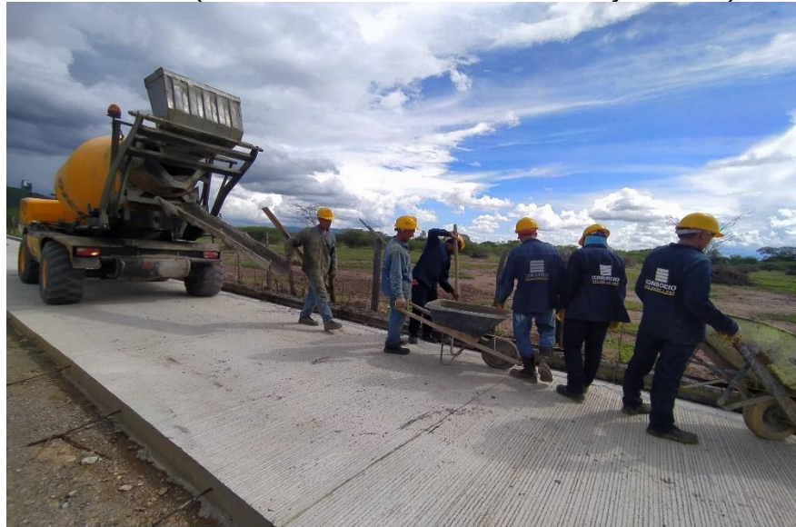
Figura 10. La Paz Cesar (Vaciado de concreto de cuneta y bordillo).
