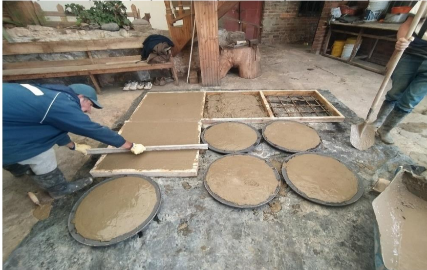
Figura 11. Monguít - Boyacá (Tapas de cajas de inspección y tapas de pozos).
