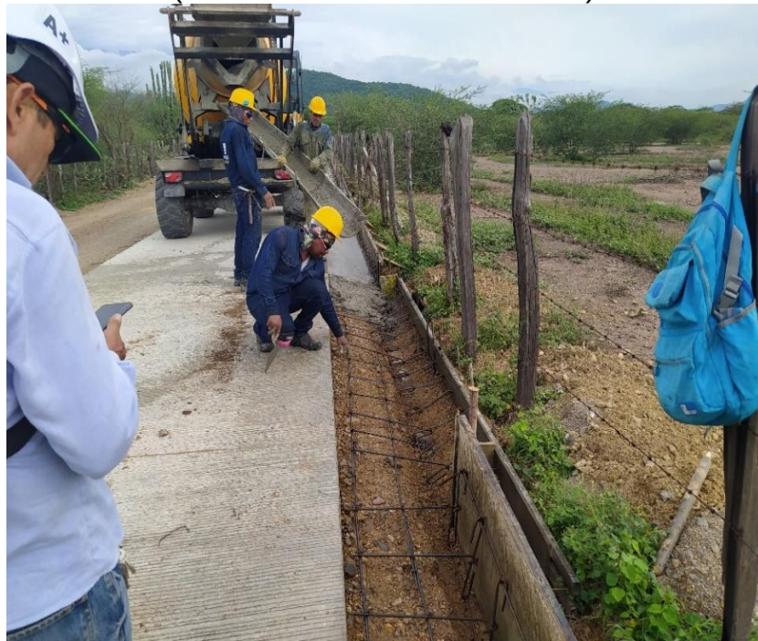
Figura 14. La Paz Cesar (Vaciado de concreto de cuneta).
