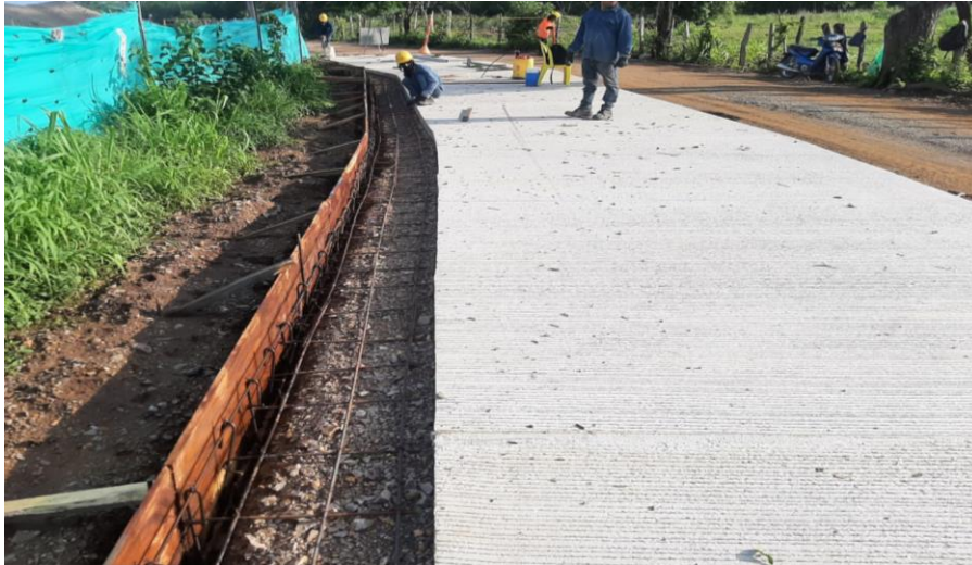
Figura 22. La Paz Cesar (Canastillas para soporte de dovelas).
