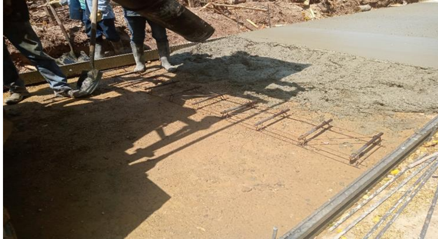
Figura 21. La Paz Cesar (Canastillas para soporte de dovelas).
