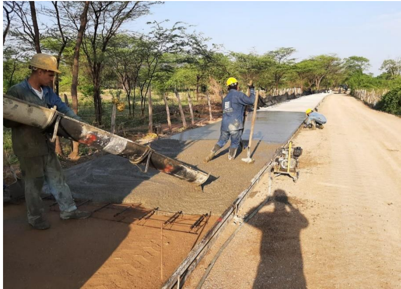
Figura 19. La Paz Cesar (Instalación de acero de transferencia).
