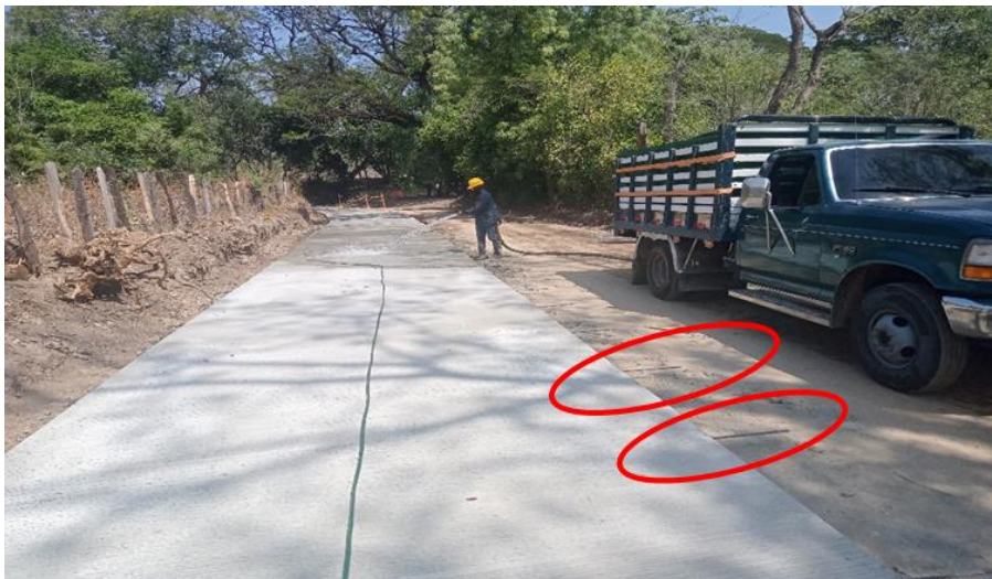
Figura 20. La Paz Cesar (Instalación de varillas de amarre).
