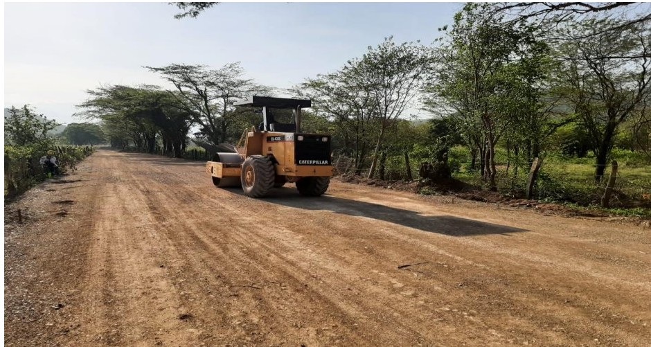
Figura 16. La Paz Cesar (Compactación de material de relleno)
