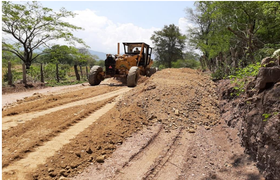
Figura 15. La Paz Cesar (Esparcimiento de material de relleno)
