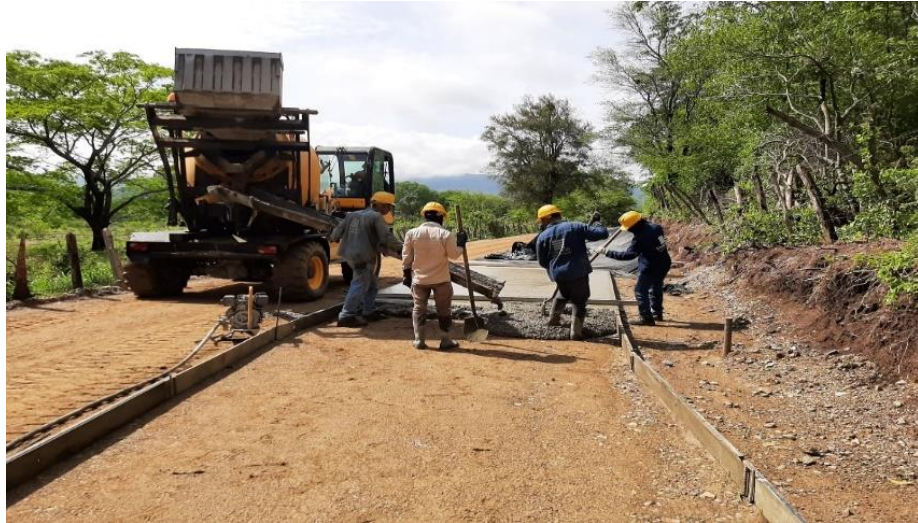
Figura 17. La Paz Cesar (Vaciado de relleno)
