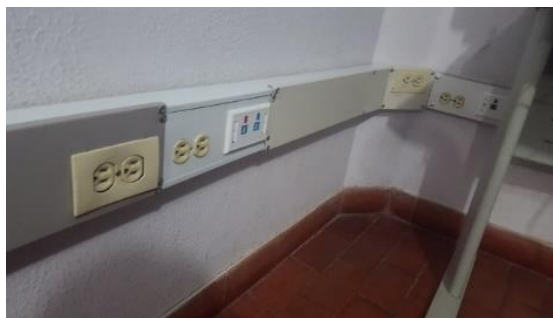
Fotografía 13. Instancian final de la canaleta en la sala de cómputo.
