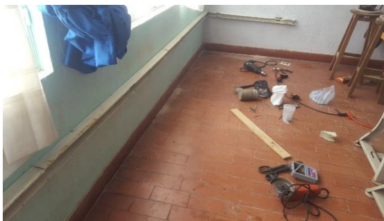
Fotografía 14. Instalación de canaleta aula de modistería.
