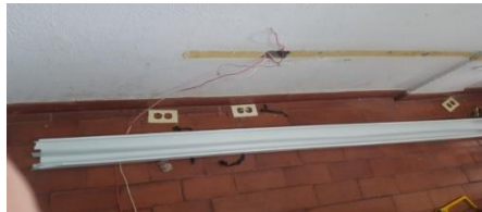
Fotografía 9. Instalación de la canaleta en el aula de sistemas.
