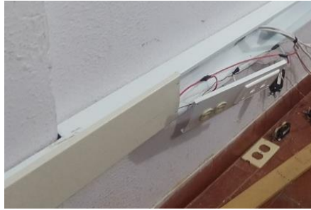
Fotografía 11.Instalacion en el aula de sistemas.
