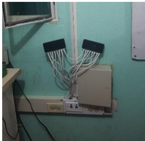
Fotografía 12.Conexion de los computadores a los switch para la red LAN.
