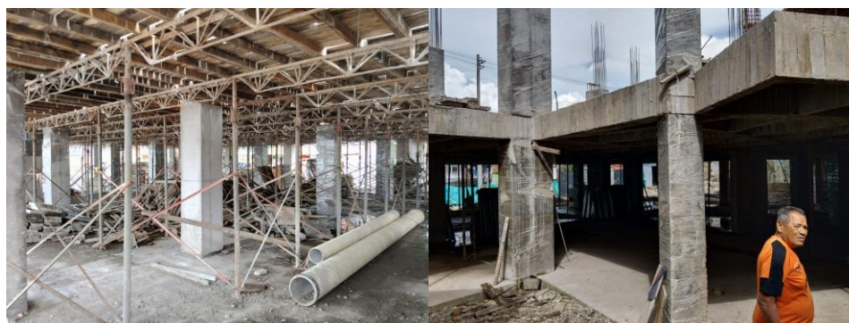
Construcción del Centro de Desarrollo Infantil Brisas del Guatiquía. Fotos tomadas: 23.06.2025.
