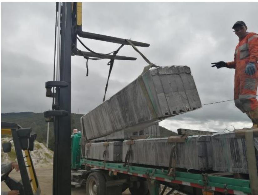
Figura 10. Inspección visual evidencia 6
