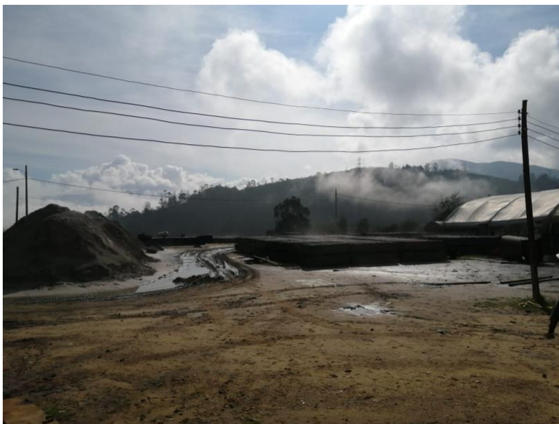
Figura 7. Inspección visual evidencia 3
