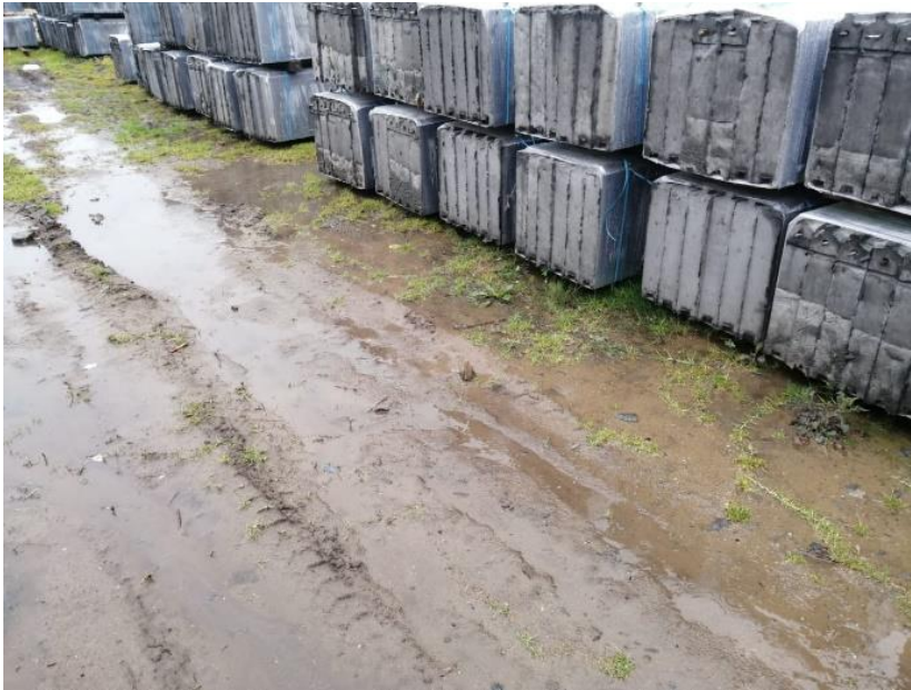
Figura 8. Inspección visual evidencia 4
