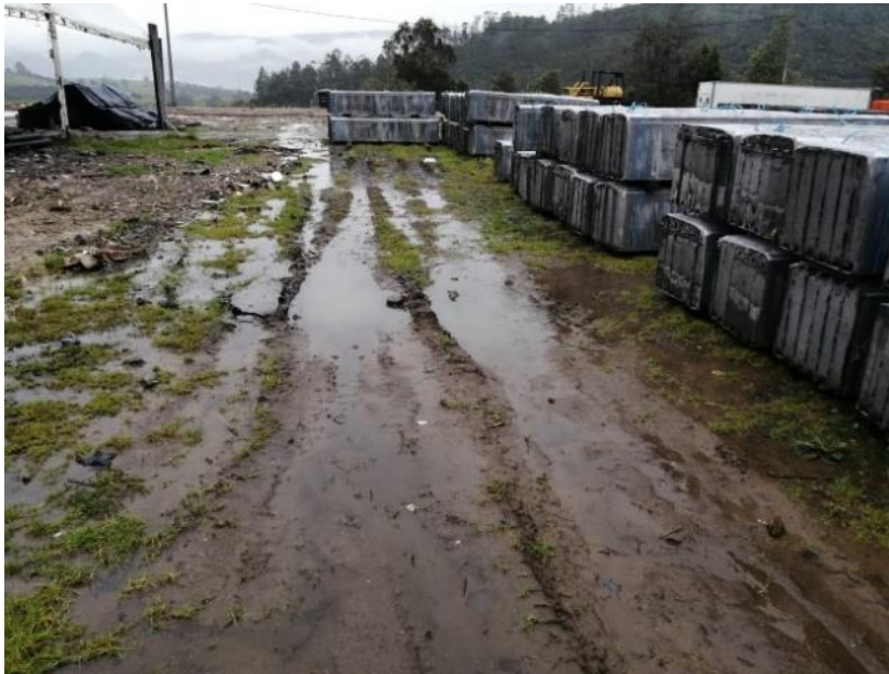
Figura 5. Inspección visual evidencia 1
