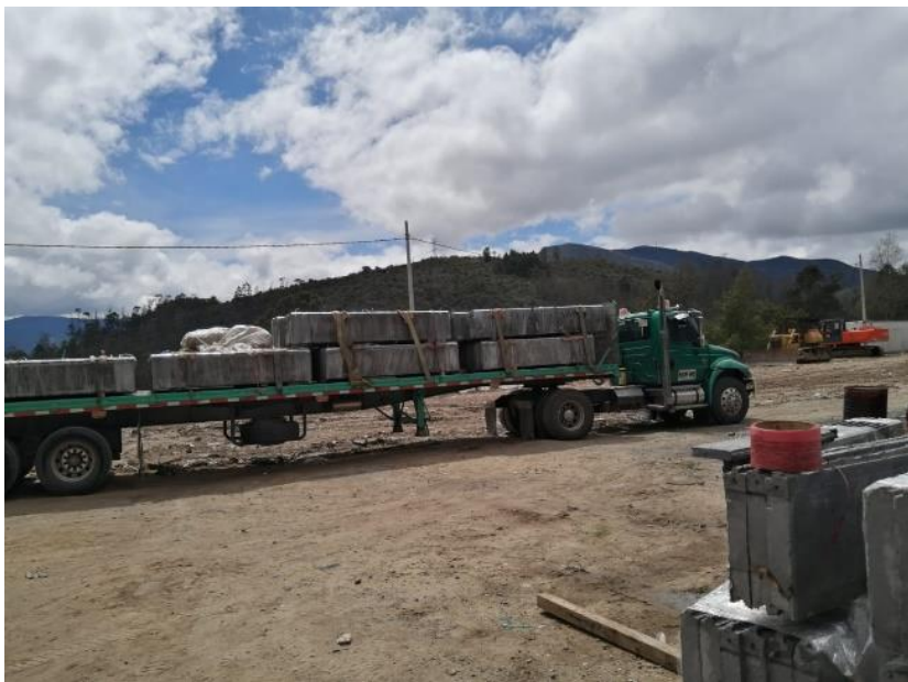
Figura 9. Inspección visual evidencia 5
