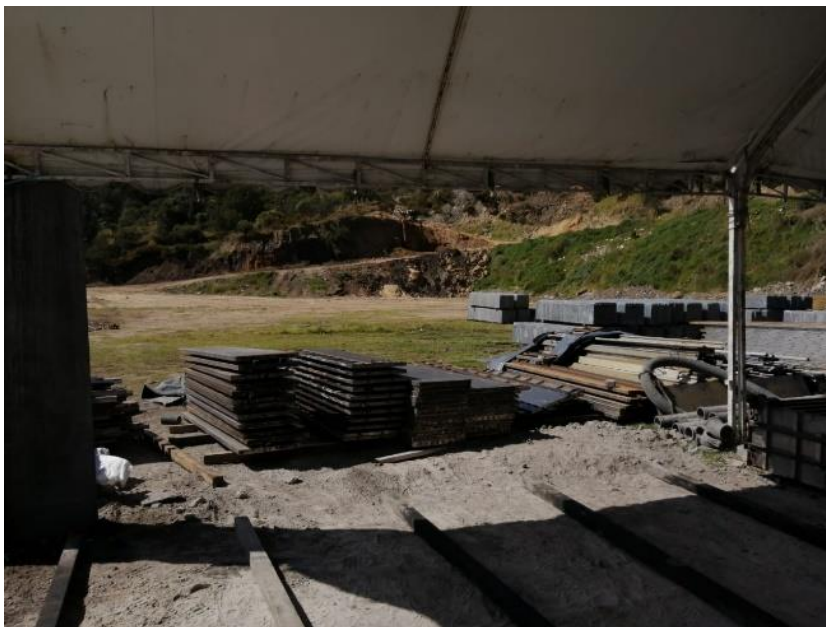
Figura 6. Inspección visual evidencia 2
