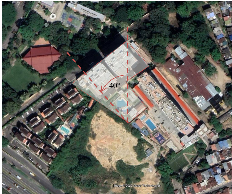
Figura 15. Vista aérea del conjunto residencial Bellomonte.
