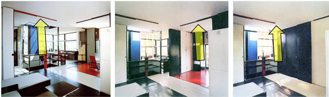
Figura 42. Detalle e los rieles y de los tabiques
