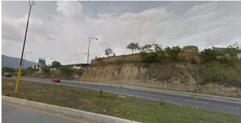
Figura 9. Panorámica antes del conjunto residencial Gran Alicante
