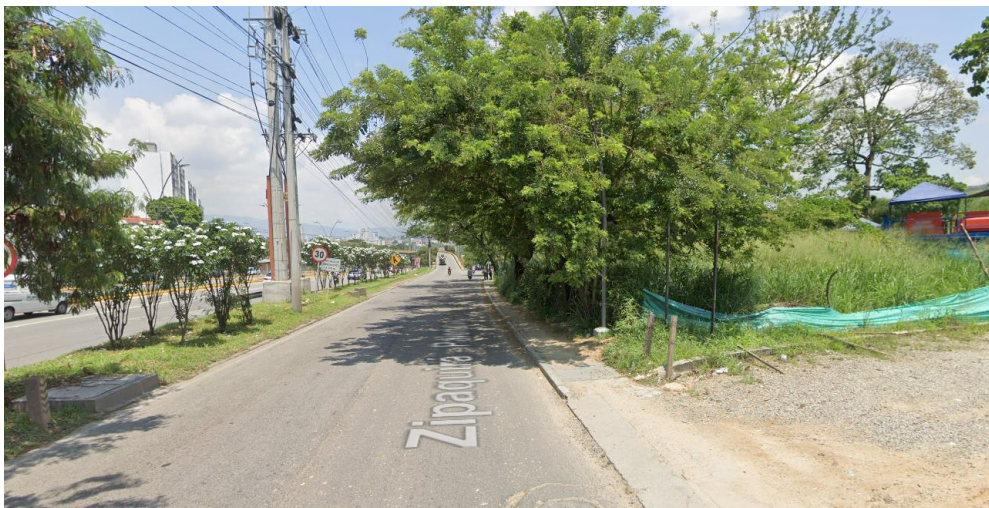
Figura 119. Estado actual de la paralela oriental
