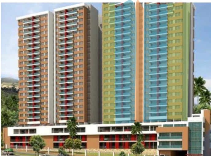
Figura 20. Conjunto residencial Bellomonte
