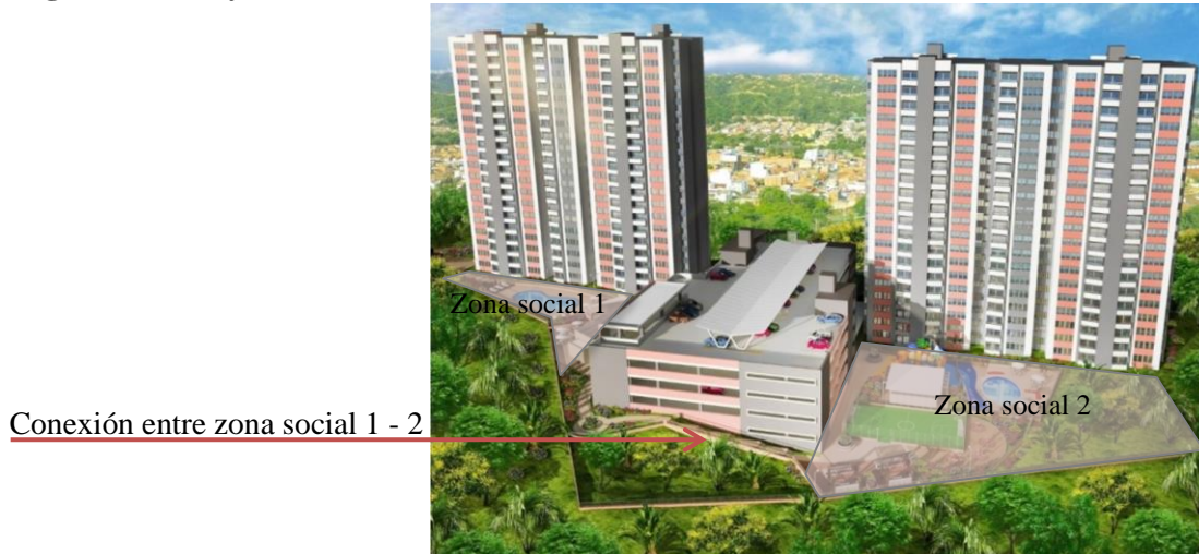
Figura 11. Conjunto residencial Gran Alicante, Girón
