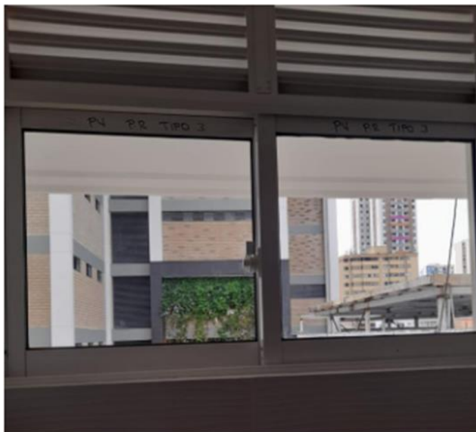
Figura 17. Obra central Park fase II, avance de obra en ventanas, apartamentos tipo 3.
