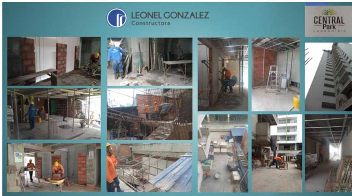
Figura 13. Obra central Park fase II, avance de obra.
