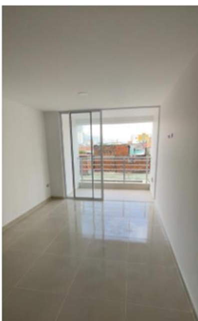
Figura 18. Obra central Park fase II, avance de obra en ventanas, apartamentos tipo 2 puerta balcón.
