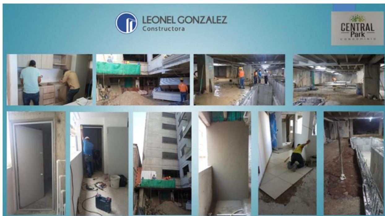
Figura 12. Obra Central Park fase II, avance en obra.
