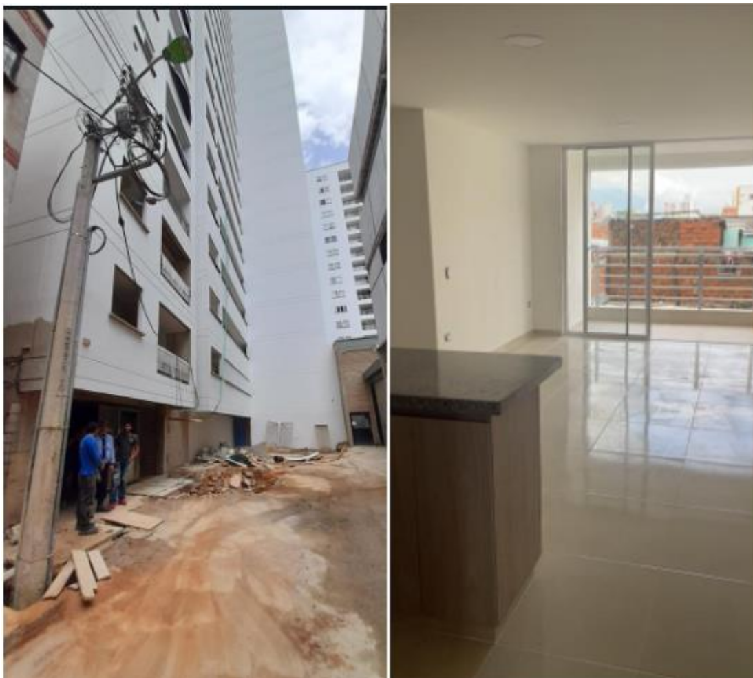
Figura 26. Obra central Park fase II, avance de actividades fachada.
