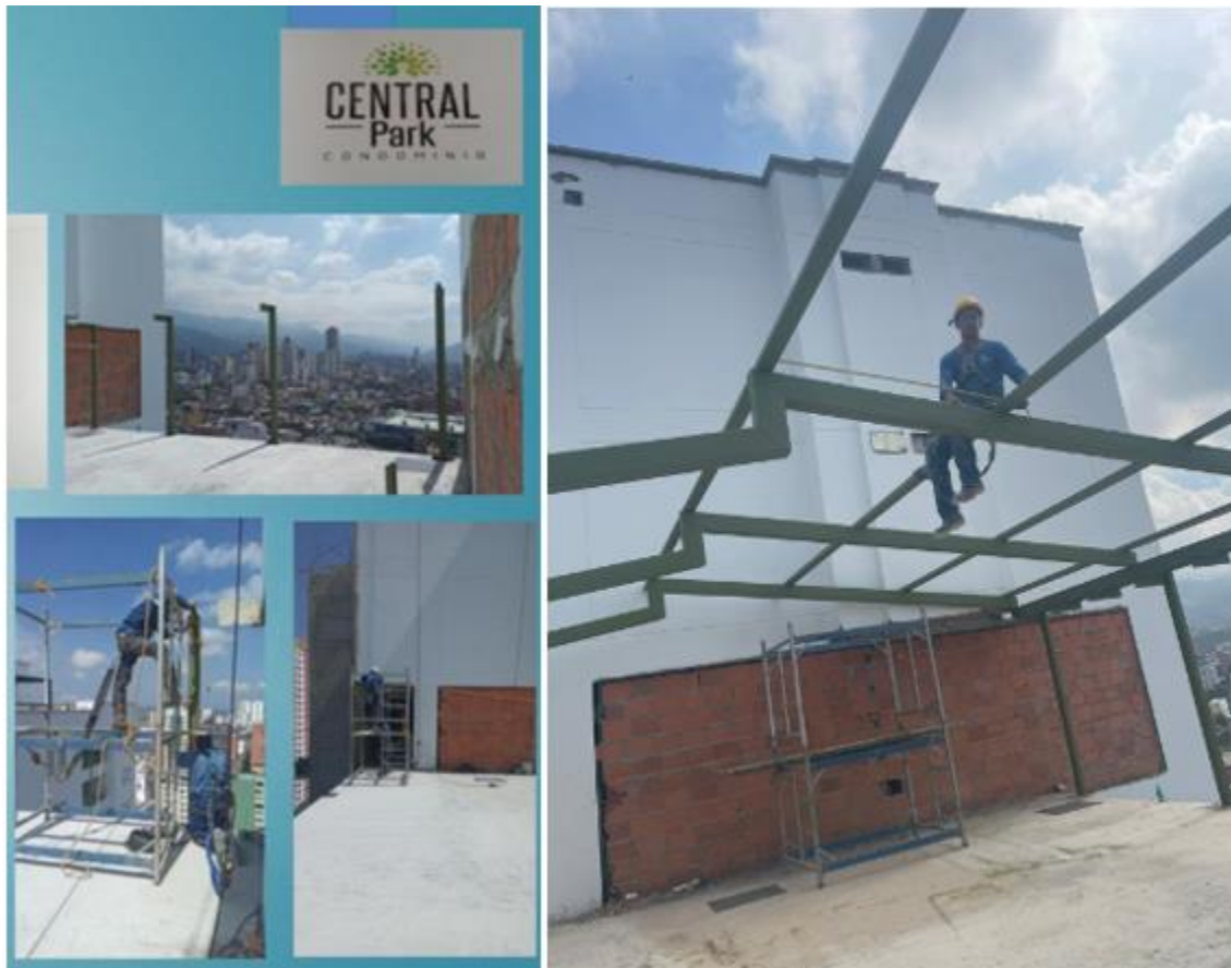
Figura 34. Obra central Park fase II, avance de obra puente peatonal.
