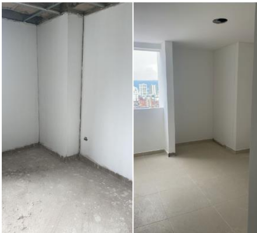
Figura 20. Obra central Park fase II, avance de actividades en enchape en apartamentos.
