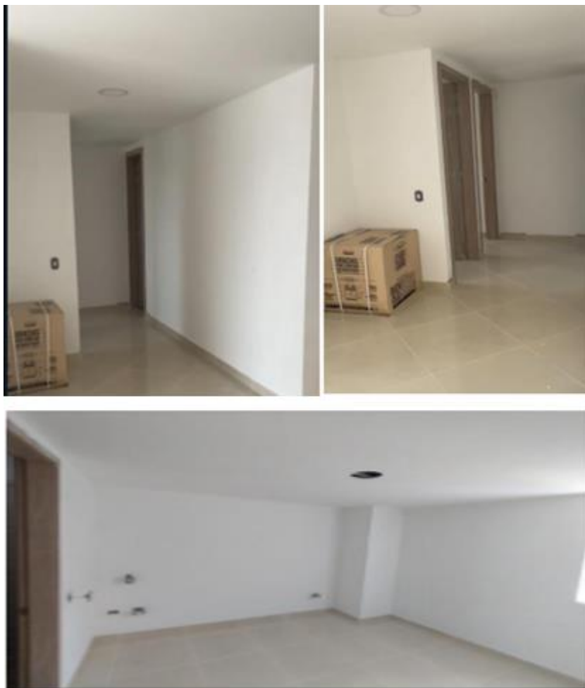
Figura 23. Obra central Park fase II, avance de actividades en pintura de apartamentos.
