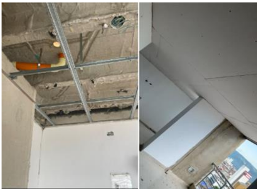
Figura 19. Obra central Park fase II, avance de actividades en Drywall en apartamentos.
