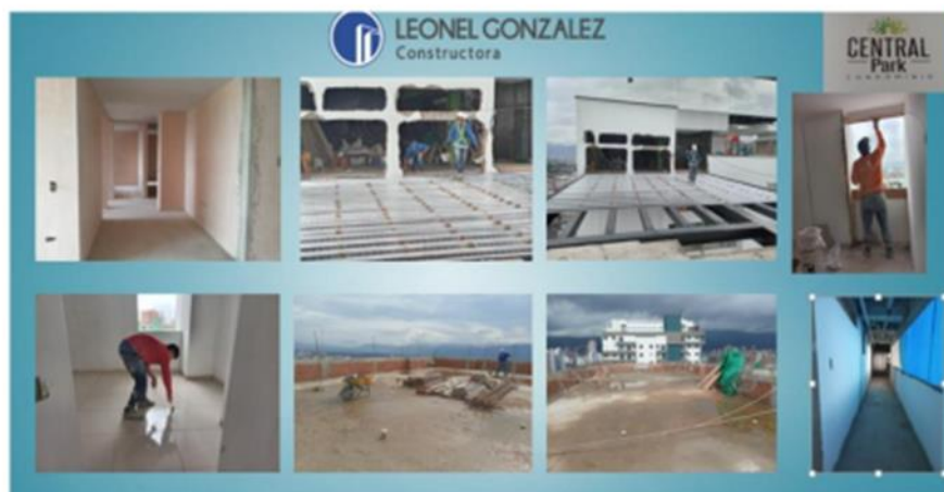
Figura 3. Obra Central Park Fase II, avance de actividades de obra.
