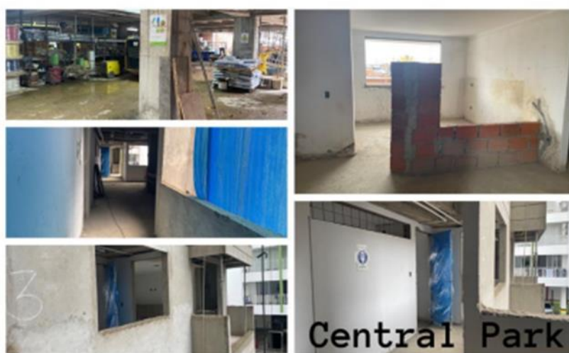
Figura 2. Evidencia estado de la obra Central Park fase II.
