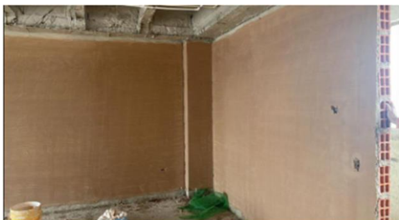
Figura 22. Obra Central Park fase II, avance de actividades en pintura de apartamentos.
