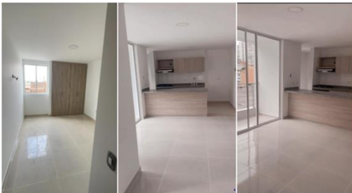
Figura 25. Obra Central Park fase II, avance de actividades en ventanas, enchape, carpintería, Drywall.
