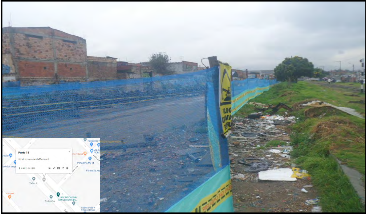
Ilustración 30. Construcción Avenida Ferrocarril con Carrera 112. Elaboración propia.
