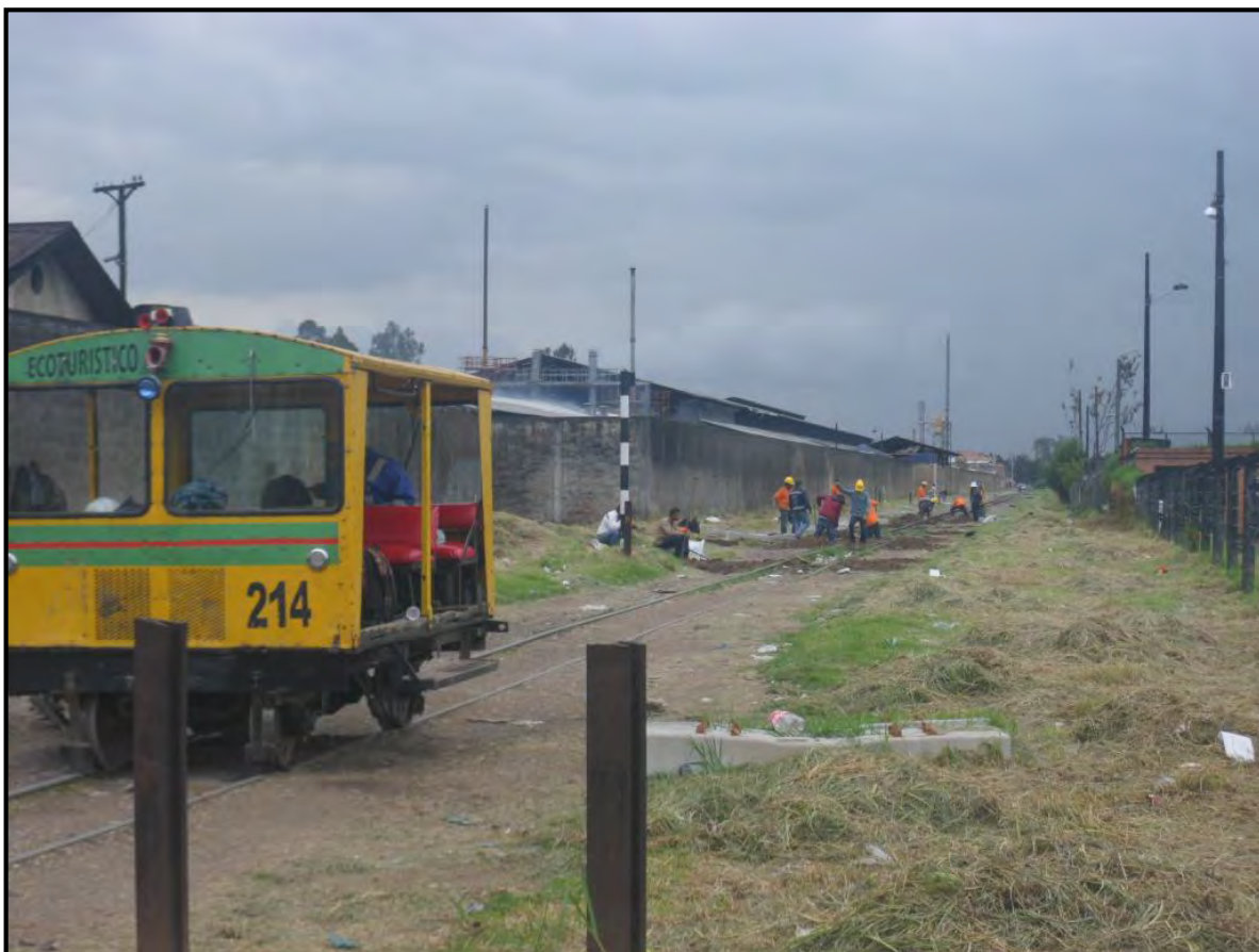
Ilustración 33. Trabajadores realizando mantenimiento Consorcio IBINES-Férreo (Calle 22 con Carrera 116). Elaboración propia.
