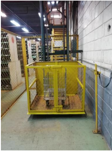
Imagen 7 elevador en fase intermedia de modificación
