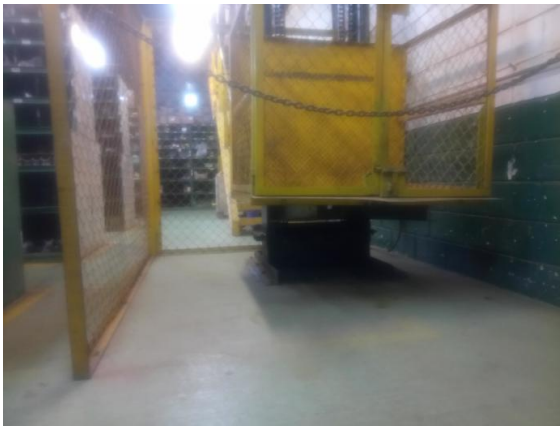
Imagen 3 vista frontal elevador
