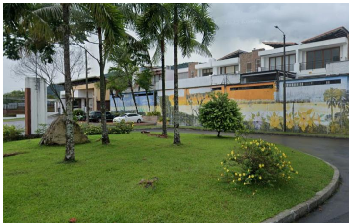
Figura 47 IMG. De referencia: Carrera 56. Fachada Principal Conjunto cerrado Umabari
