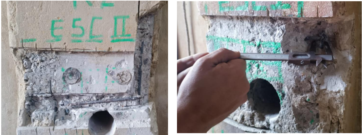
Figura 15 Escarificación de concreto en columnas
