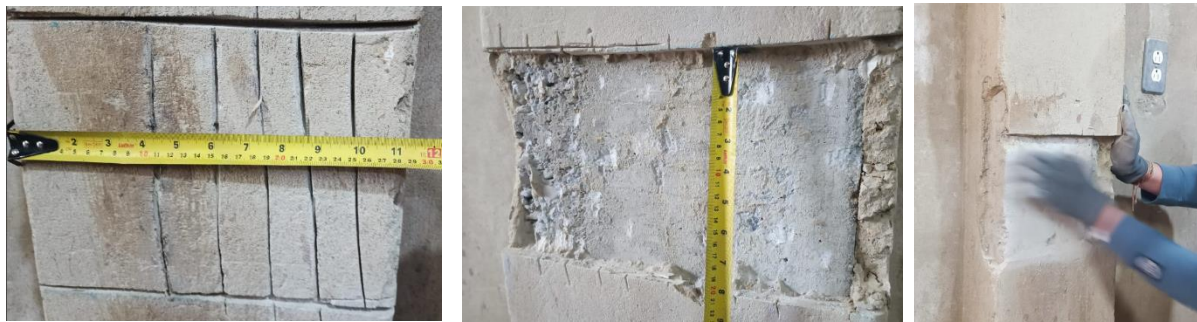
Figura 11 Alistamiento de superficies para ensayos no destructivos
