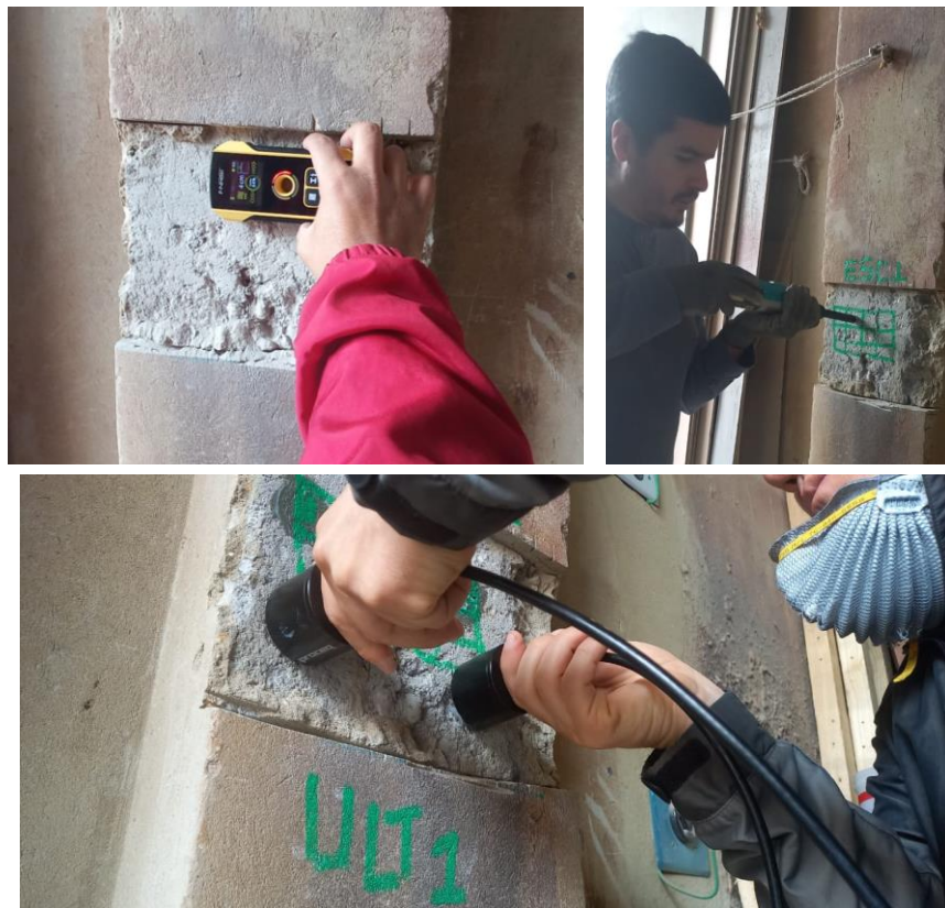
Figura 23 Equipamiento en obra
