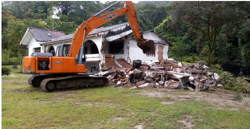
Figura 28. Demolición del costado Occidental de la Casa Quinta. fuente Rocha, L. Ruiz, D (2018)
