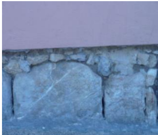
Figura 4. Díaz, C. (2009), Cimientos en piedra a la vista de la casa de la cultura de Villavicencio (figura). Recuperado de http://www.javeriana.edu.co/biblos/tesis/arquitectura/tesis26.pdf
