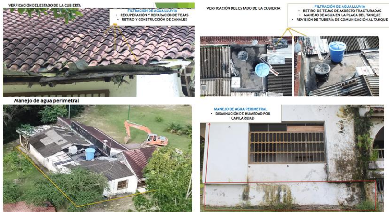
Figura 22. Mitigación de Humedad en la Vivienda, fuente Rocha, L. Ruiz, D (2018)
