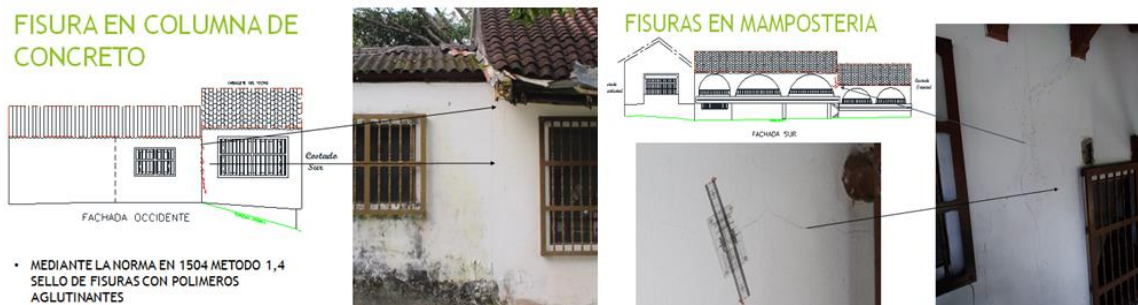
Figura 27. Reparación de fisuras en Casa Quinta, fuente Rocha, L. Ruiz, D (2018)
