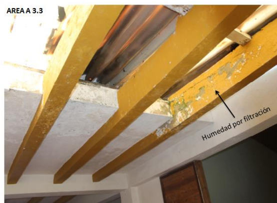
Figura 24. Mitigación de Humedad en la Vivienda, fuente Rocha, L. Ruiz, D (2018)
