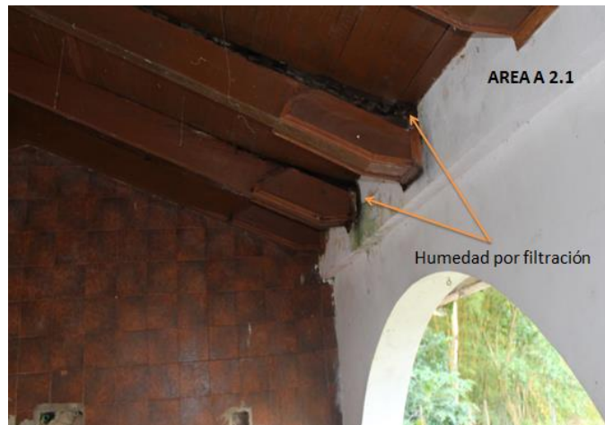
Figura 25. Mitigación de Humedad en la Vivienda, fuente Rocha, L. Ruiz, D (2018)
