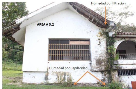
Figura 23. Mitigación de Humedad en la Vivienda, fuente Rocha, L. Ruiz, D (2018)
