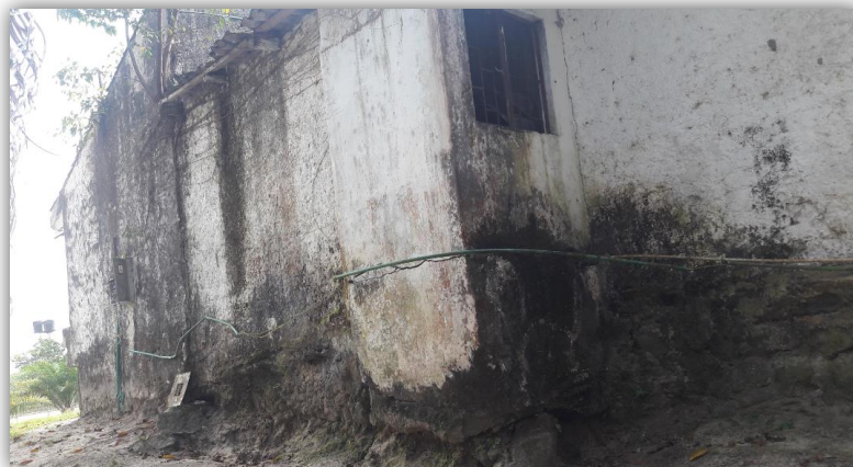
Cimentación fachada Occidental
