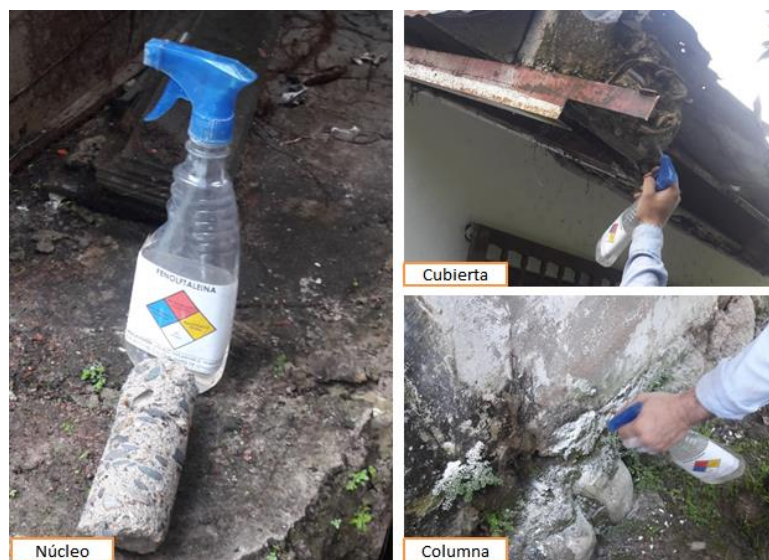
Figura 15. Ensayo de carbonatación mediante aplicación de Fenolftaleína. fuente Rocha, L. Ruiz, D (2018)
