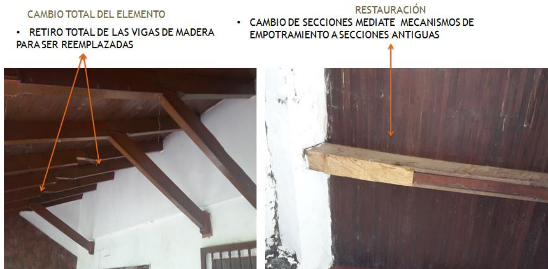
Figura 21. Reparación de estructuras en Madera área 3.1 y 2.1. fuente Rocha, L. Ruiz, D (2018)
