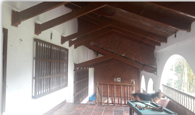
Estructura de la Cubierta en Hall 1 y Hall 2
