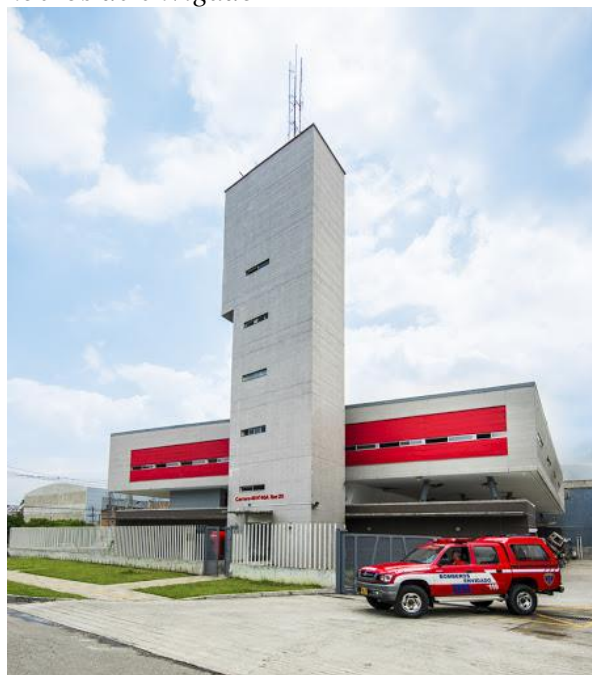
Figura 28. Estación de bomberos de envigado
