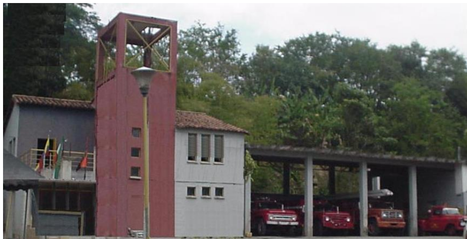
Figura 5. Estación de bomberos de Piedecuesta
