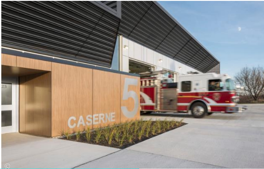
Figura 22. Estación de bomberos#5
