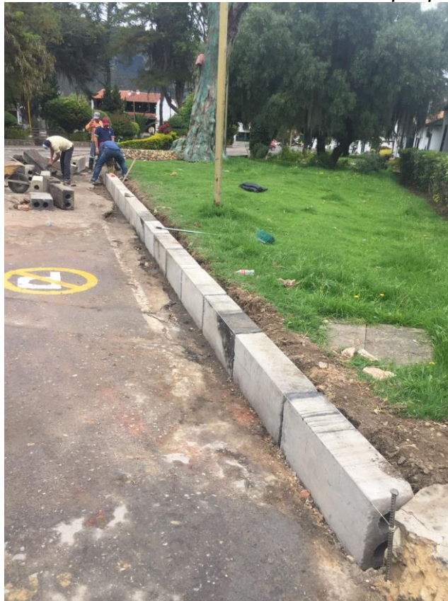
Imagen 30. Instalación de sardineles en Parque principal.
