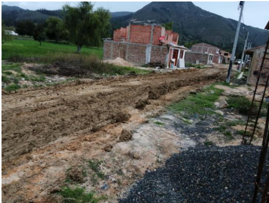
Imagen 22. Urbanización antes de la intervención
