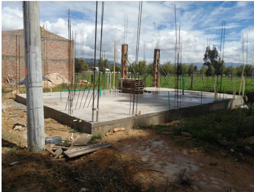
Imagen 31. Visita a obras en la Urbanización El Paraíso.
