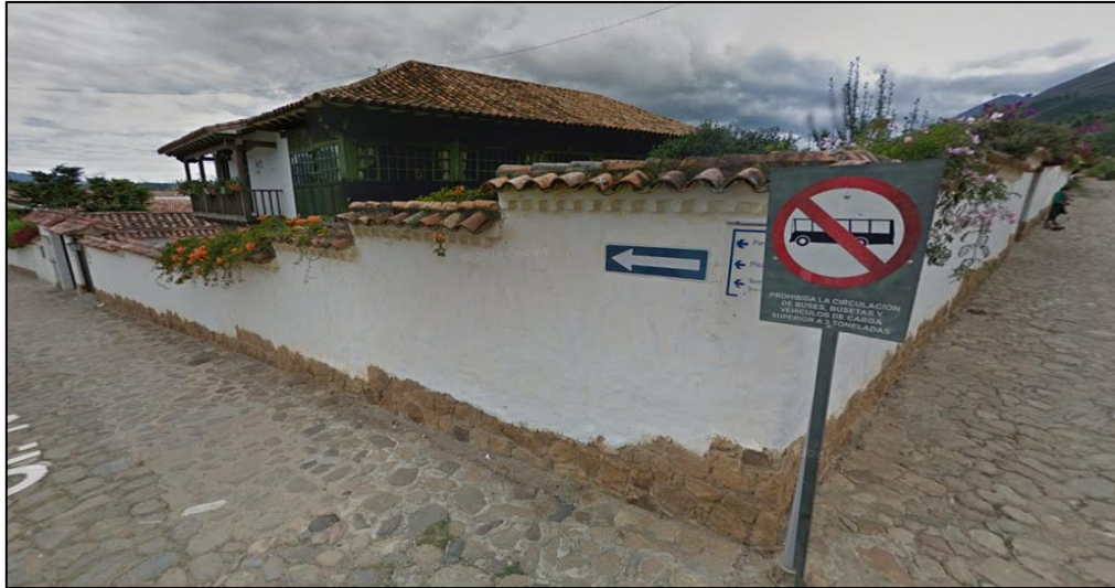
Fotografía 5: Tipología antigua de Vivienda, Fuente: Google Maps.
