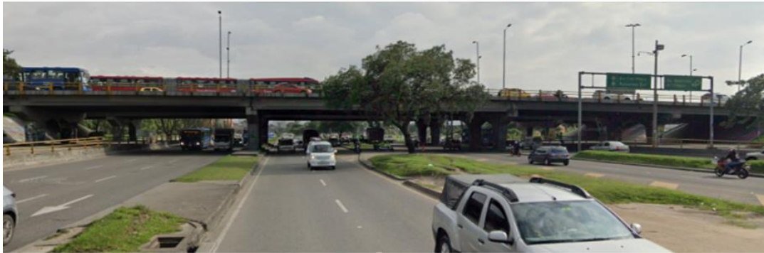
Figura 2: ID 1, Puente Vehicular Costado Norte
