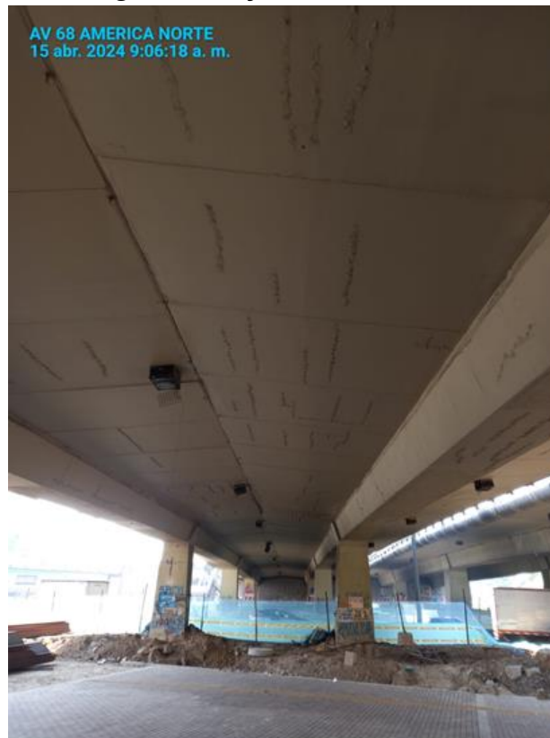
Figura 28: Inyección de fisuras
