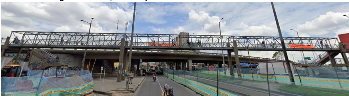
Figura 23: ID 3, Puente peatonal - Costado norte cruce Av-68.
