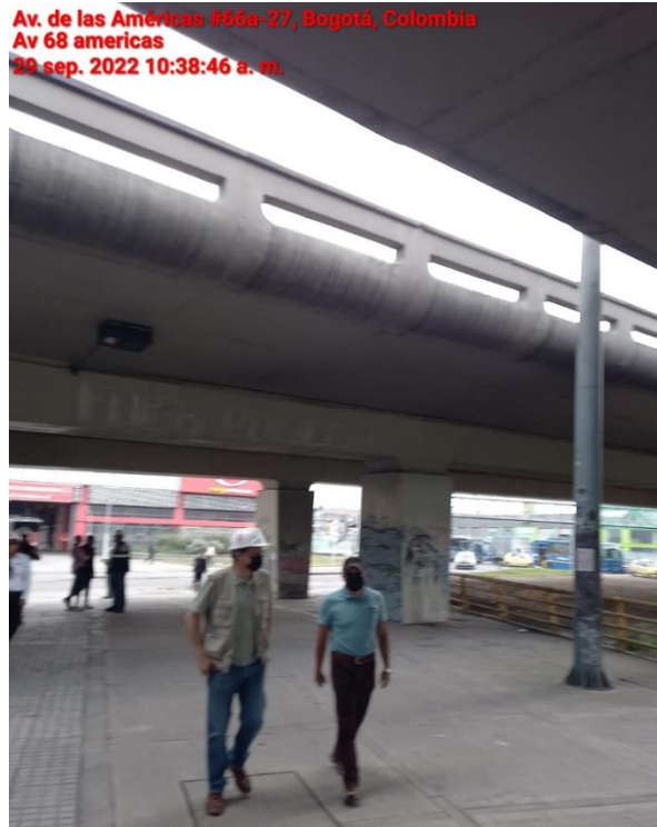
Figura 6: Fotografía zona inferior de puente Av. Américas con Av. 68
