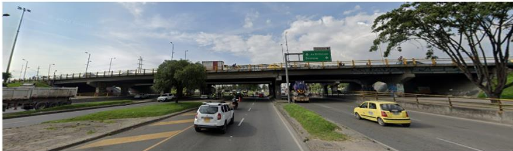
Figura 3: ID 2, Puente Vehicular Costado Sur
