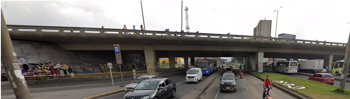
Figura 21: ID 1, Puente vehicular norte.
