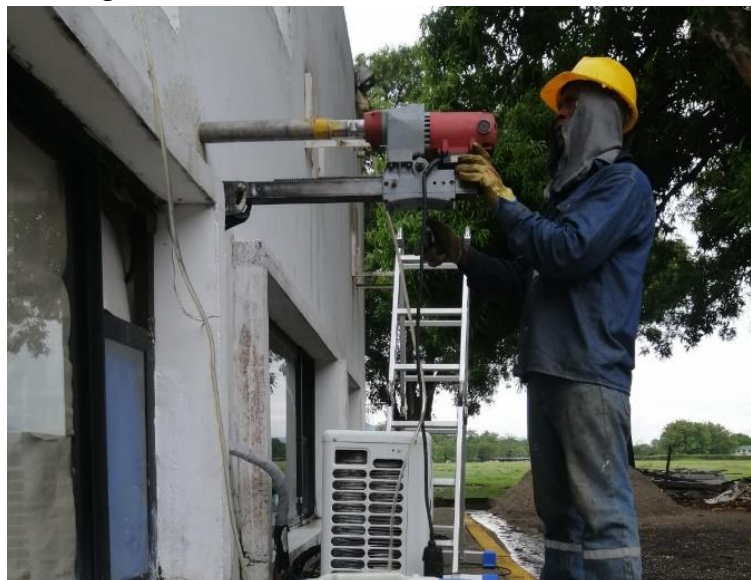
Figura 16: Taladro de extracción de núcleos.
