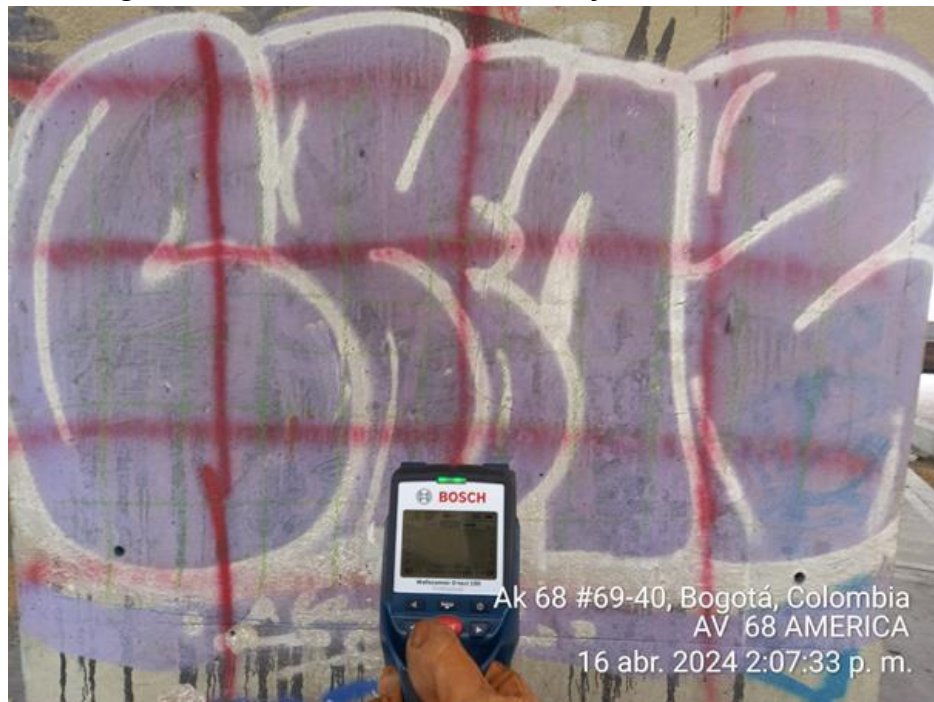
Figura 39: Ferroskan Columna 2 – Eje 4, Costado Norte
