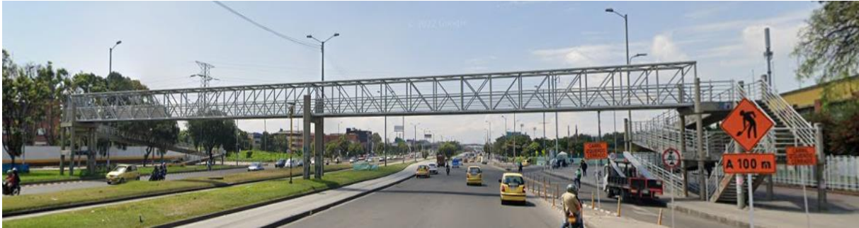
Figura 27: ID 7, Puente peatonal costado Occidental.
