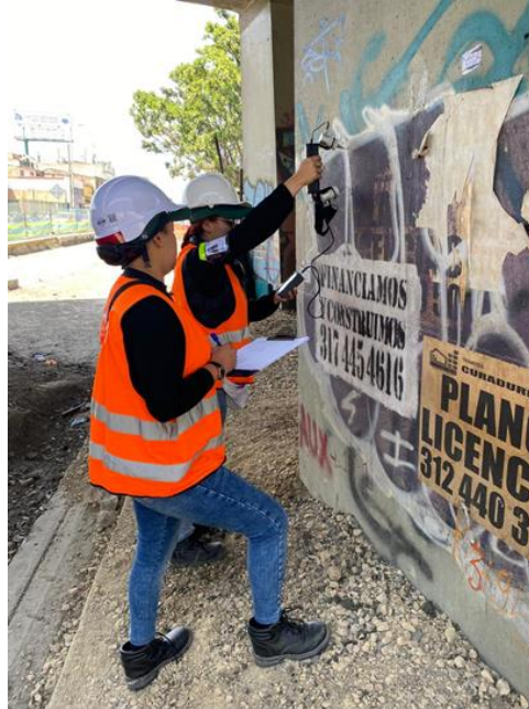
Figura 35: Escáner de refuerzo en Columna 4 – Eje 5, costado sur
