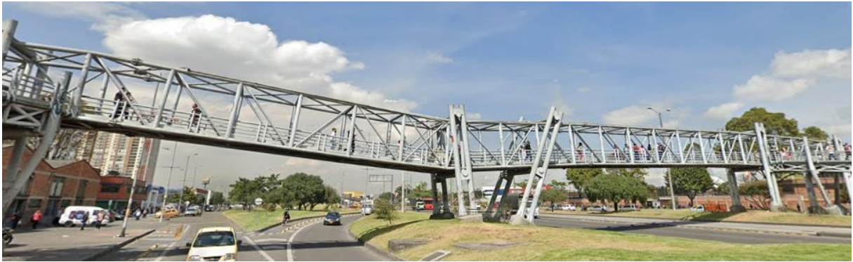
Figura 24: ID 4, Puente peatonal acceso estación Pradera.
