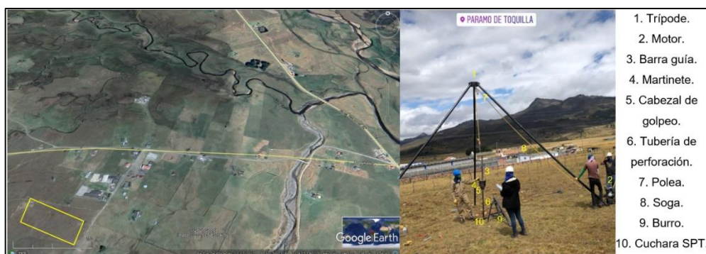
Figura 4. Equipo de perforación.
