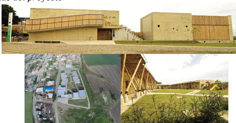
Figura 27. Fachadas del proyecto
