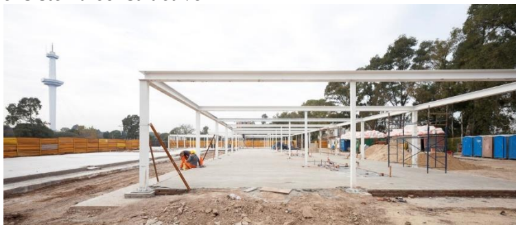
Figura 59. Fotos del sistema constructivo
