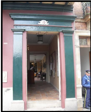
PUERTA DE ACCESO PRINCIPAL
