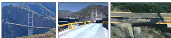
Figura 4. Puente atirantado El Carrizo (Durango-Mazatlán) durante la visita técnica. Fuente: IMT (2024).
