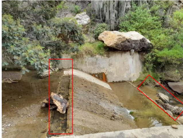
Fotografía 1. Vista de la bocatoma de la Vereda Quebrada Arriba
