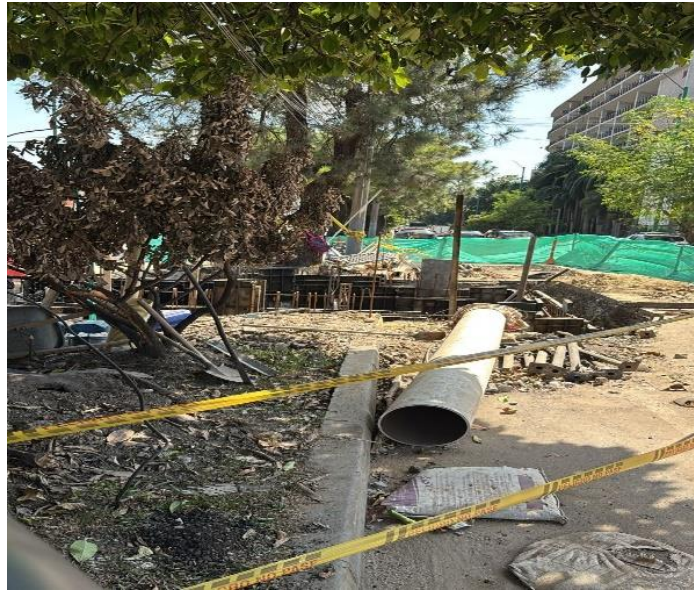
Figura 4 Visita técnica al contrato de obra No. 308 de 2023.
