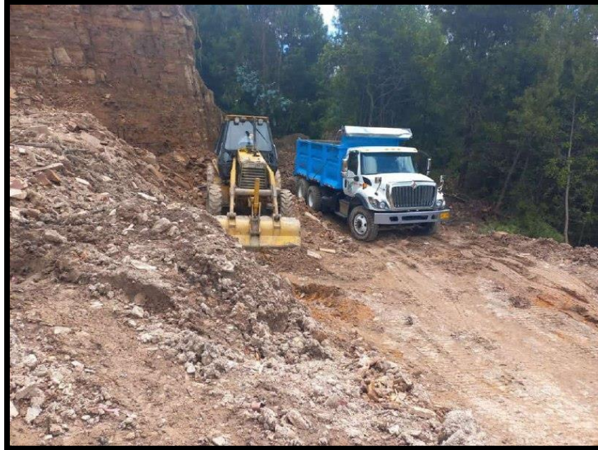
Imagen 31: extendiendo material de recebo con la retroexcavadora en la vereda Córdoba Bajo
