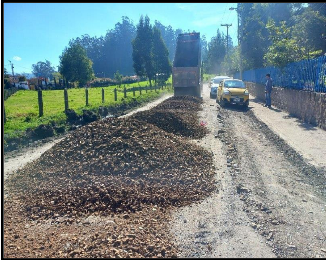
Imagen 24. Extendió material granular o afirmado (subbase)
