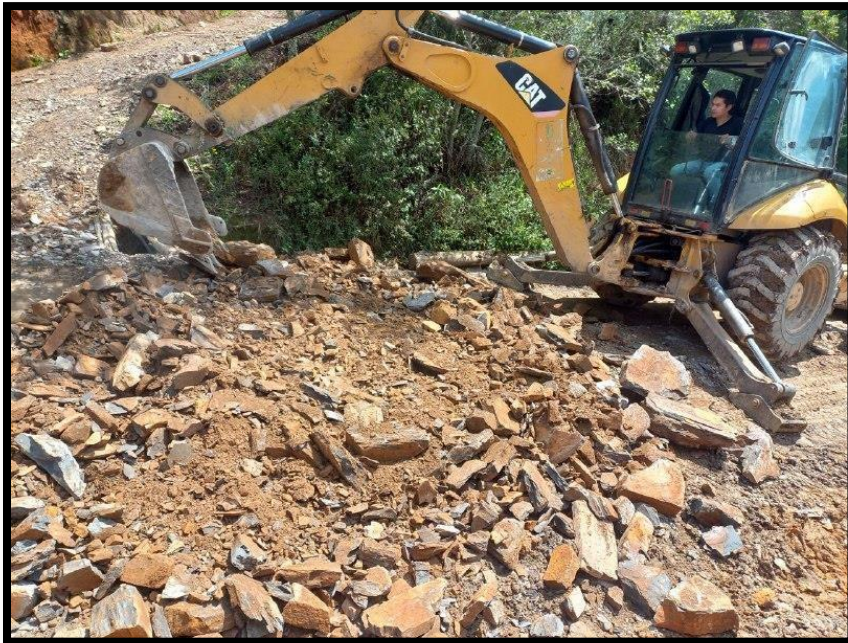
Imagen 34. Trabajo vereda sucre occidental la cual se encontraba intransitable
