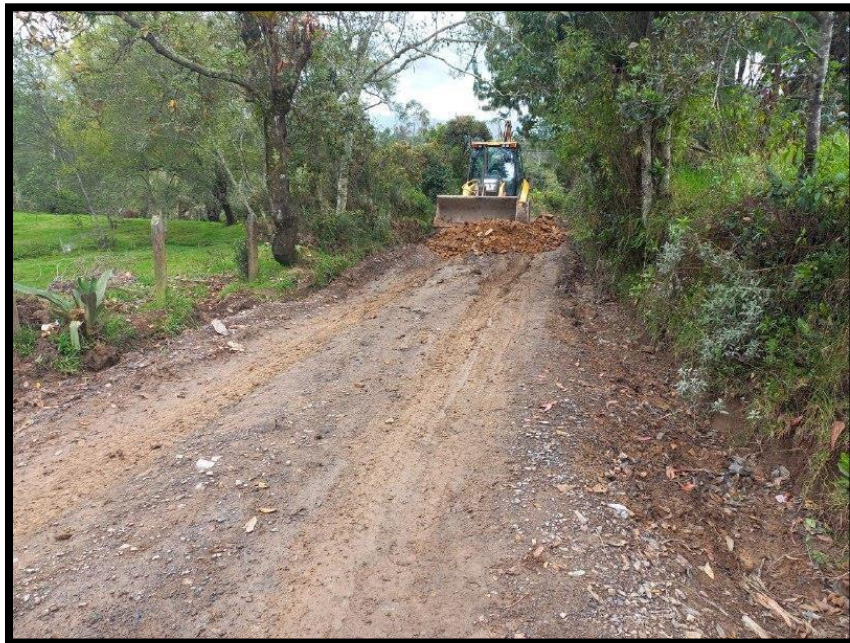
Imagen 31: extendiendo material de recebo con la retroexcavadora en la vereda Córdoba Bajo
