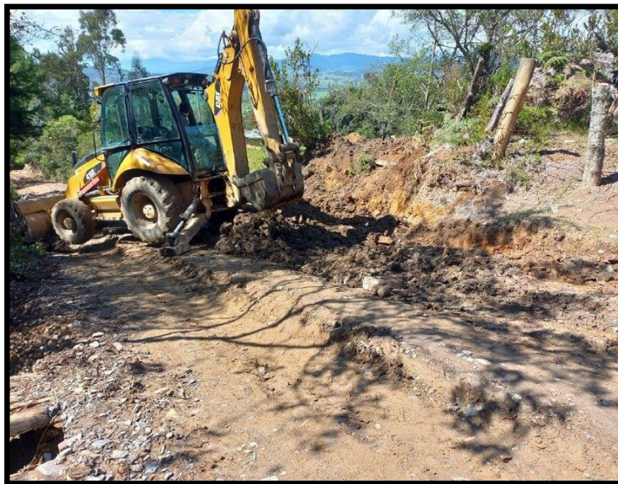
Imagen 25.La apertura y limpieza de cunetas
