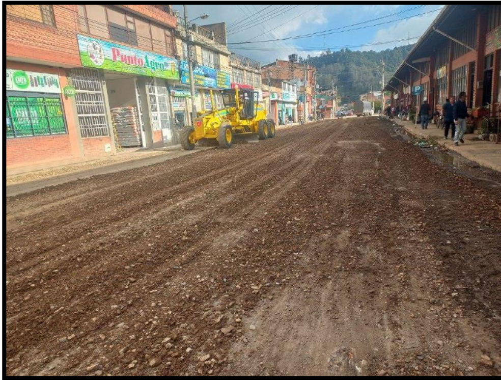
Imagen (13) nivelación y compactación del material granular subbase
