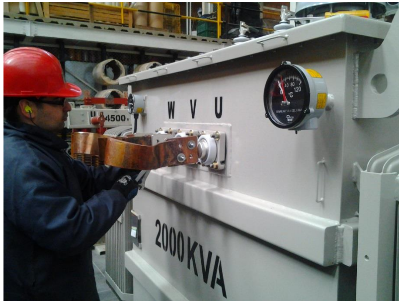
Figura. 6 Medición de resistencia de aislamiento. Fuente: Autor.
