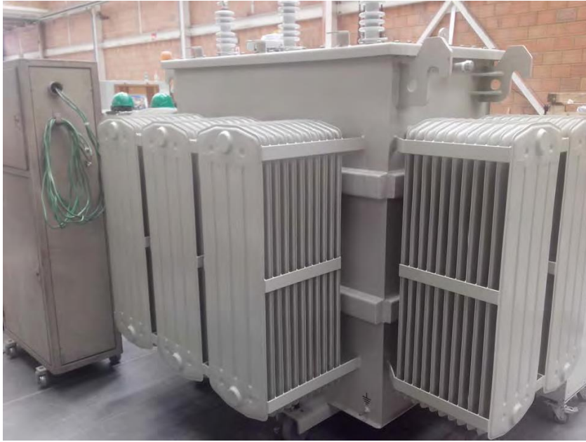
Figura. 1 Inspección a la estructura física del transformador Fuente: Autor
