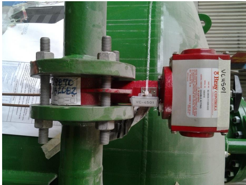
Figura. 20 Electroválvula con TAG y serial. Fuente: Autor.
