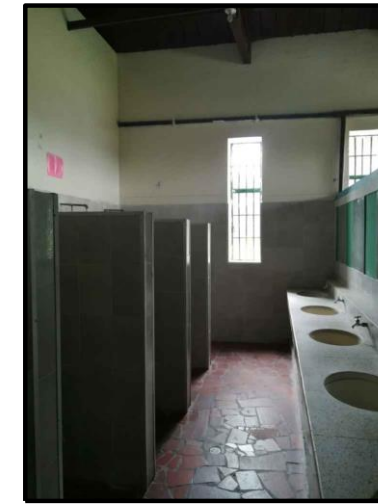
FOTO 6 BAÑOS SEGUNDA PLANTA
