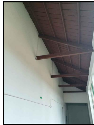
FOTO 11 CUBIERTA SEGUNDA PLANTA
