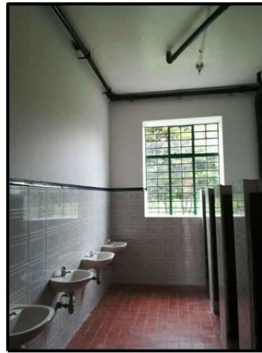
FOTO 2 BAÑOS PRIMERA PLANTA
