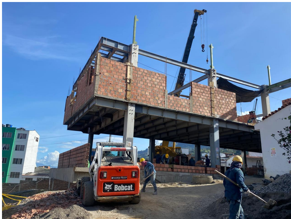
Figura 15. Apoyo constructivo con bobcat y grúa telescópica
