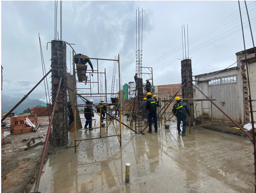
Figura 20. Fundida de columnas central de gases
