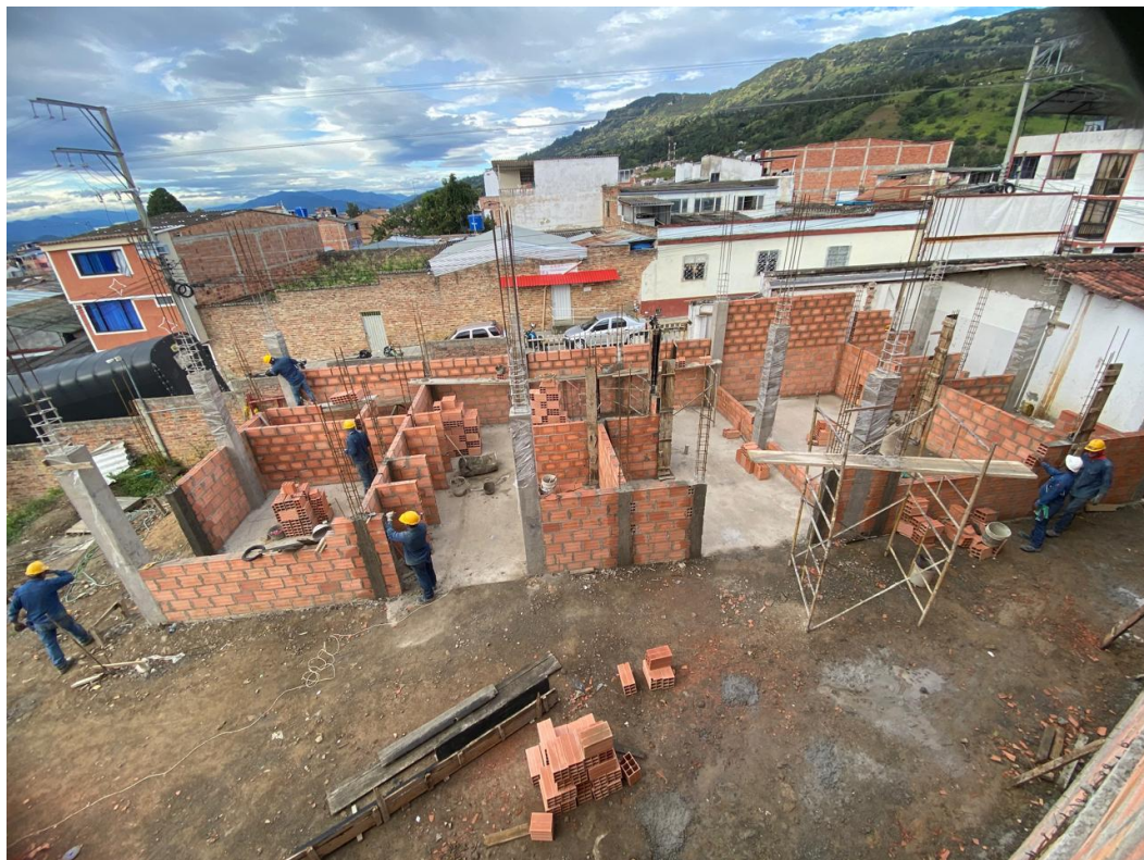
Figura 19. Levantamiento bloque de mampostería en central de gases
