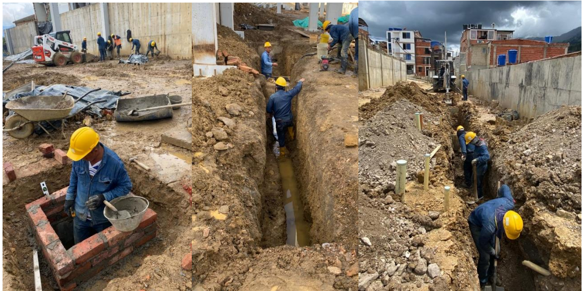
Figura 6. Excavación red sanitaria y registros
