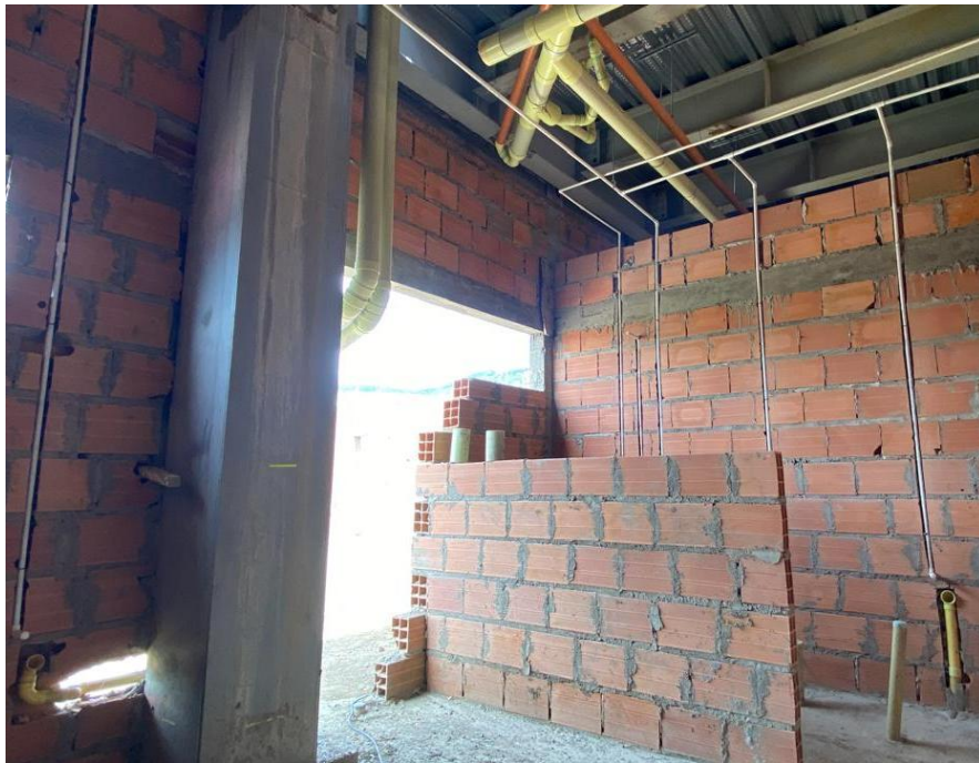
Figura 12. Red hidrosanitaria y agua potable
