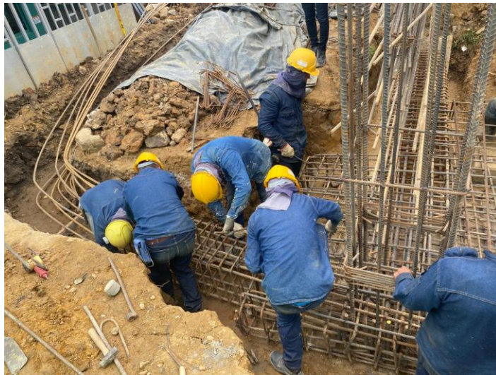
Figura 3. Instalación de acero en zapatas, viga de cimentación y pedestal
