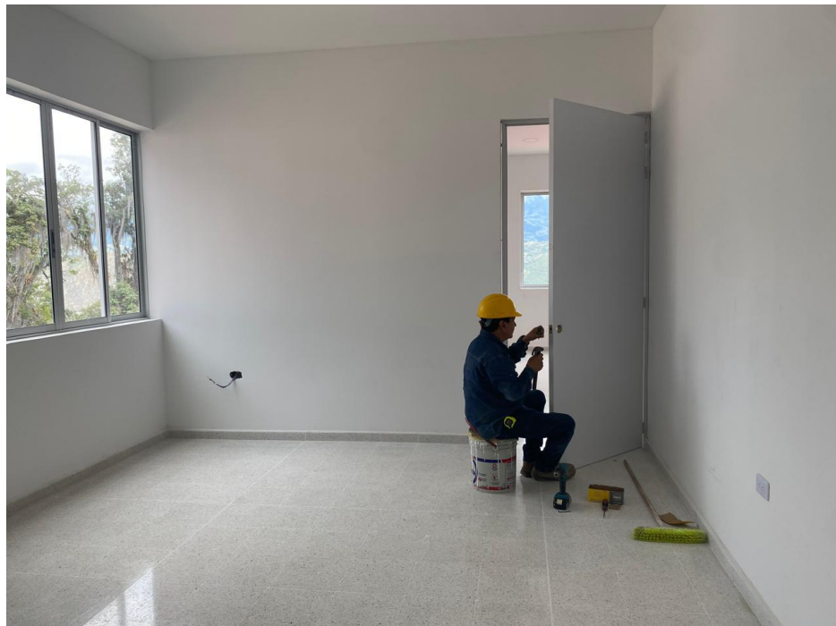
Figura 26. Ajuste de puertas interiores
