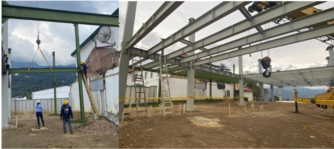
Figura 5. Izaje estructura metálica Bloque D
