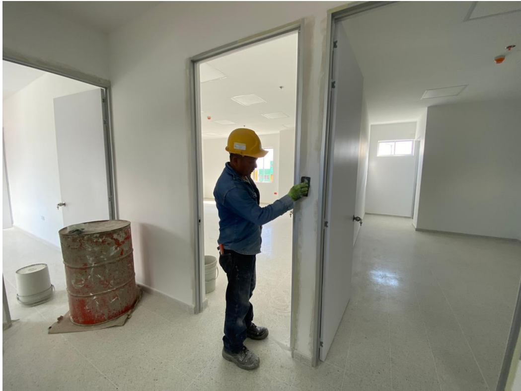
Figura 25. Instalación y ajuste de puertas interiores en fase de acabados
