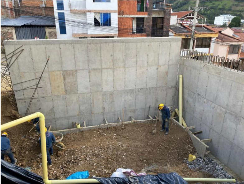
Figura 2. Muro de contención
