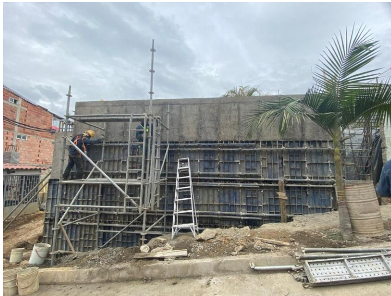
Figura 1. Desencofrado muro contención
