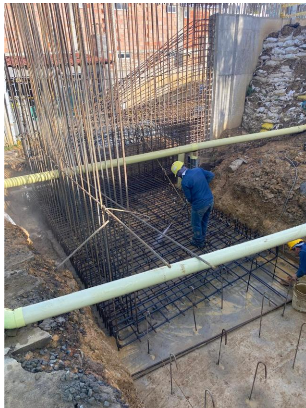
Figura 2. Instalación acero 420 MPa muro contención
