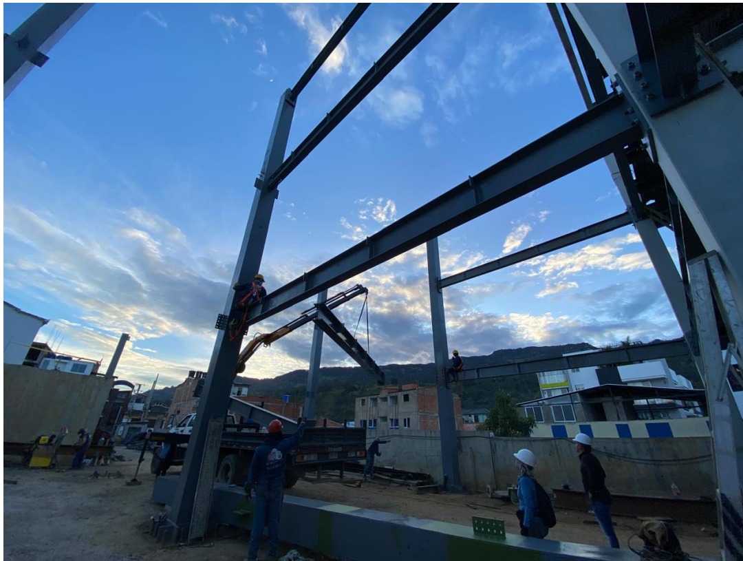
Figura 21. Izaje elementos estructurales Bloque D
