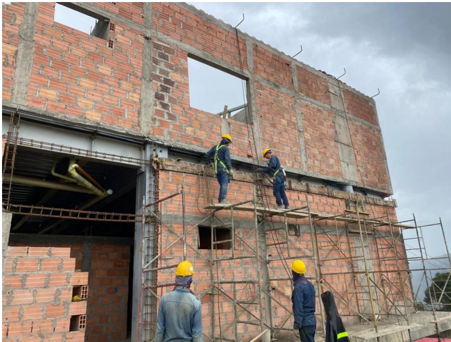
Figura 11. Muros divisorios Módulo A
