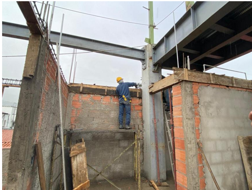
Figura 19. Levantamiento bloque de mampostería en central de gases
