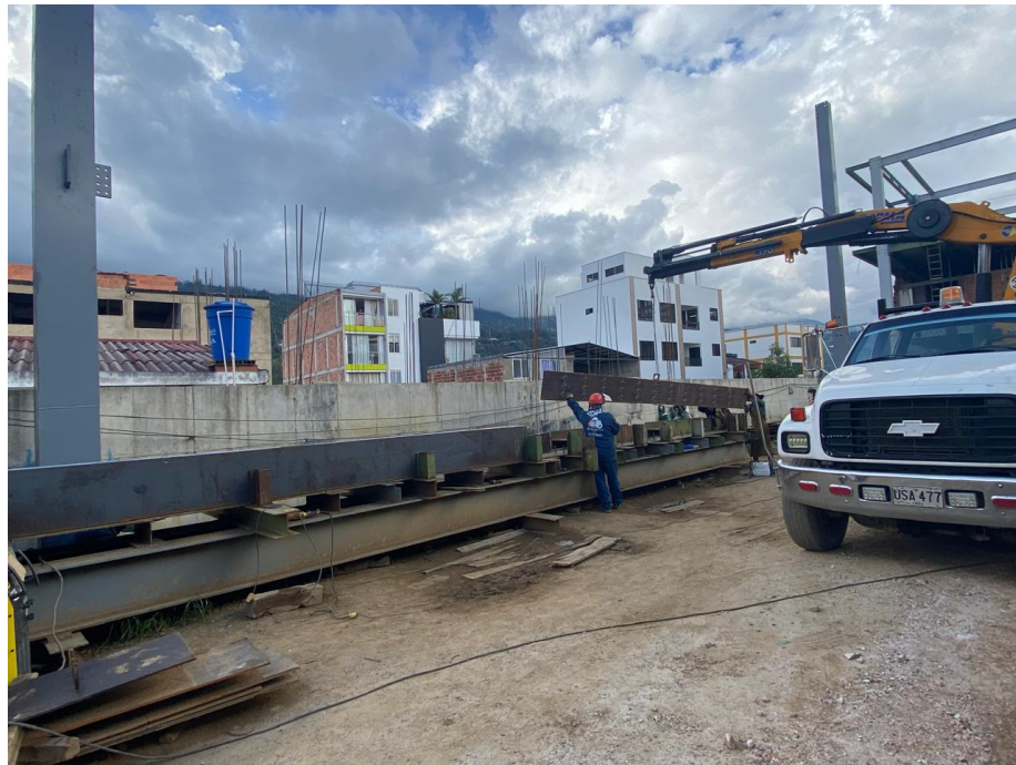
Figura 23. Posicionamiento de elementos estructurales metálicos con grúa
