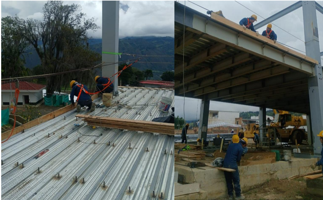
Figura 7. Encofrado losa aligerada
