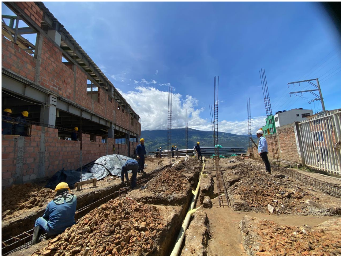
Figura 13. Conexión sanitaria a Acometida principal
