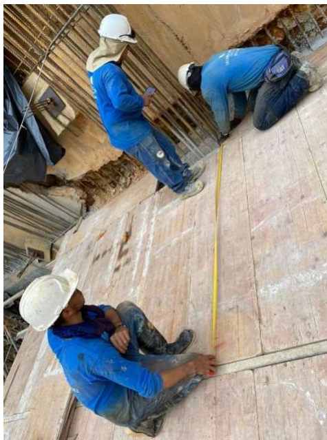
Figura 5. Seguimiento a los trabajadores y demarcación de medidas con los planos
