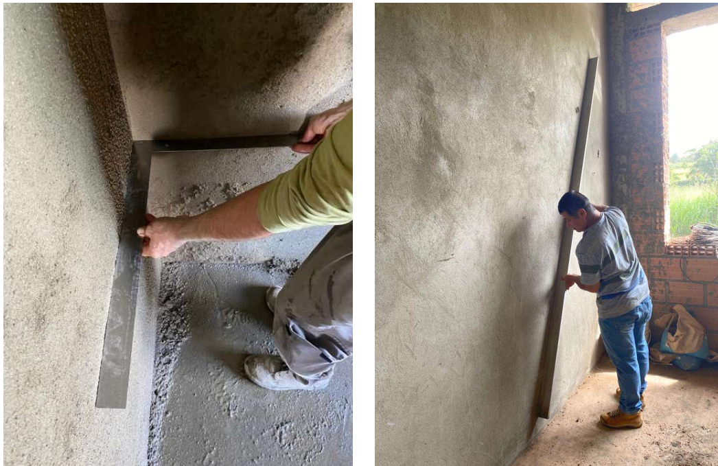
Figura 30. Rectificación de perpendicularidad en friso
