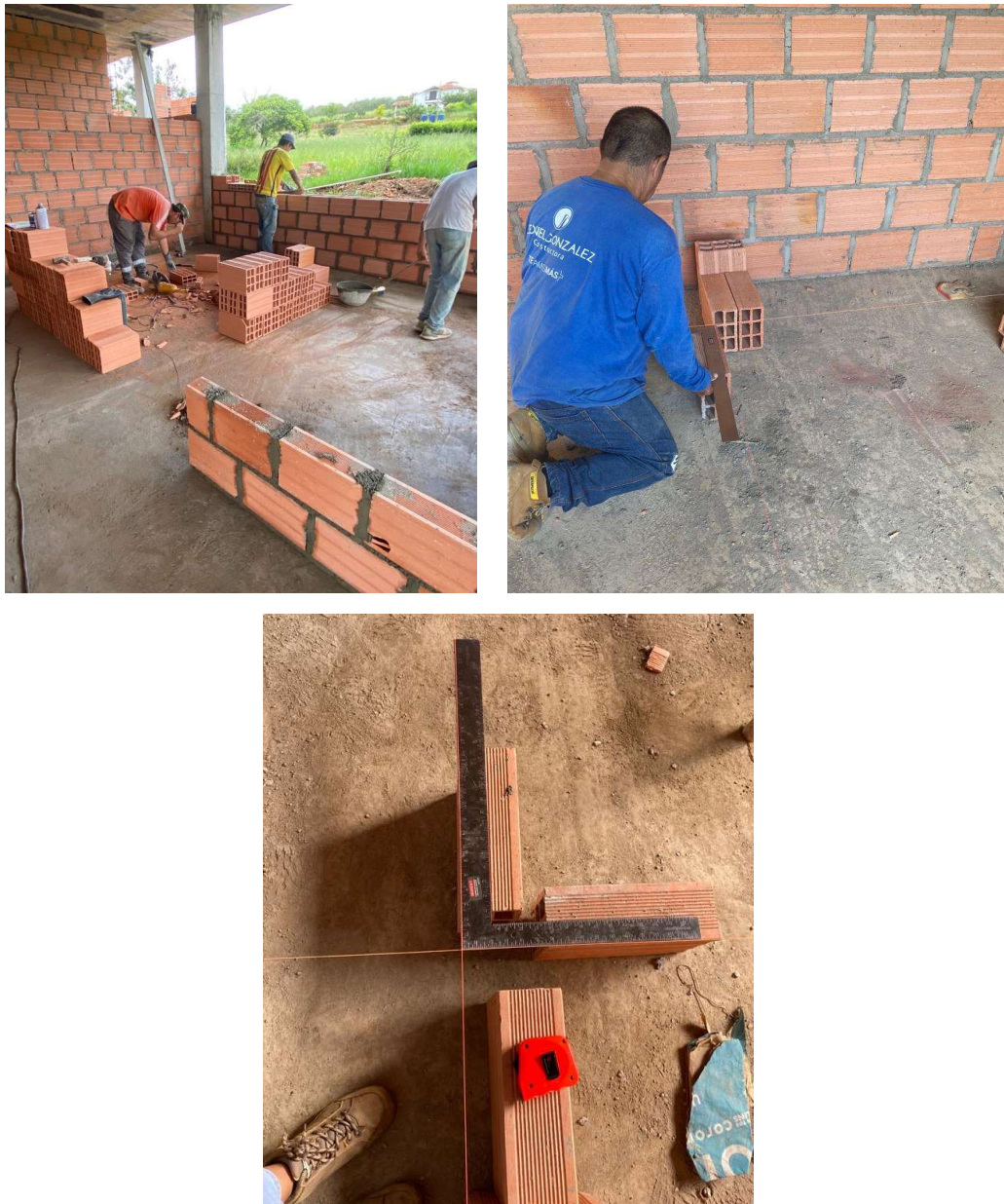
Figura 27. Revisión de mampostería
