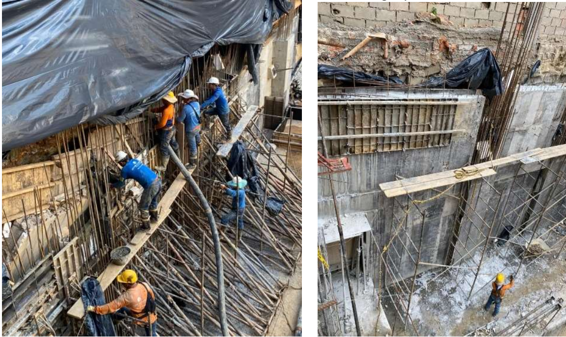
Figura 33. Fundida de muro para estabilización de talud en proyecto SANTOANGEL
