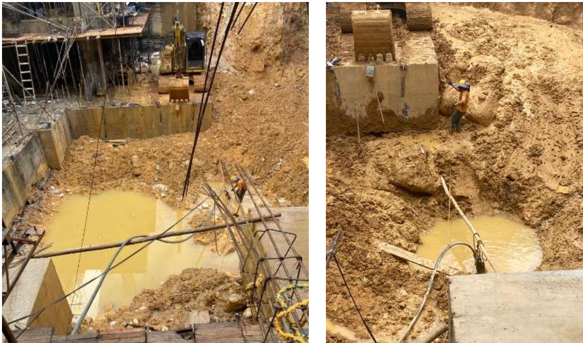
Figura 32. Succión de agua por bomba hidráulica en proyecto SANTOANGEL
