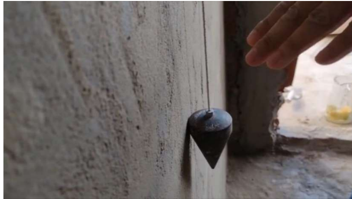
Figura 29. Rectificación de verticalidad en friso
