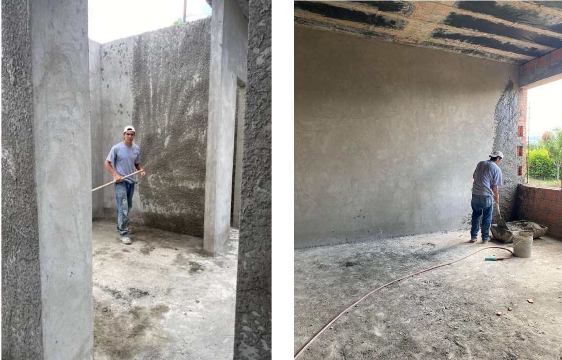
Figura 34. Técnica de chafarreo para corrección de escuadra milimétrica
