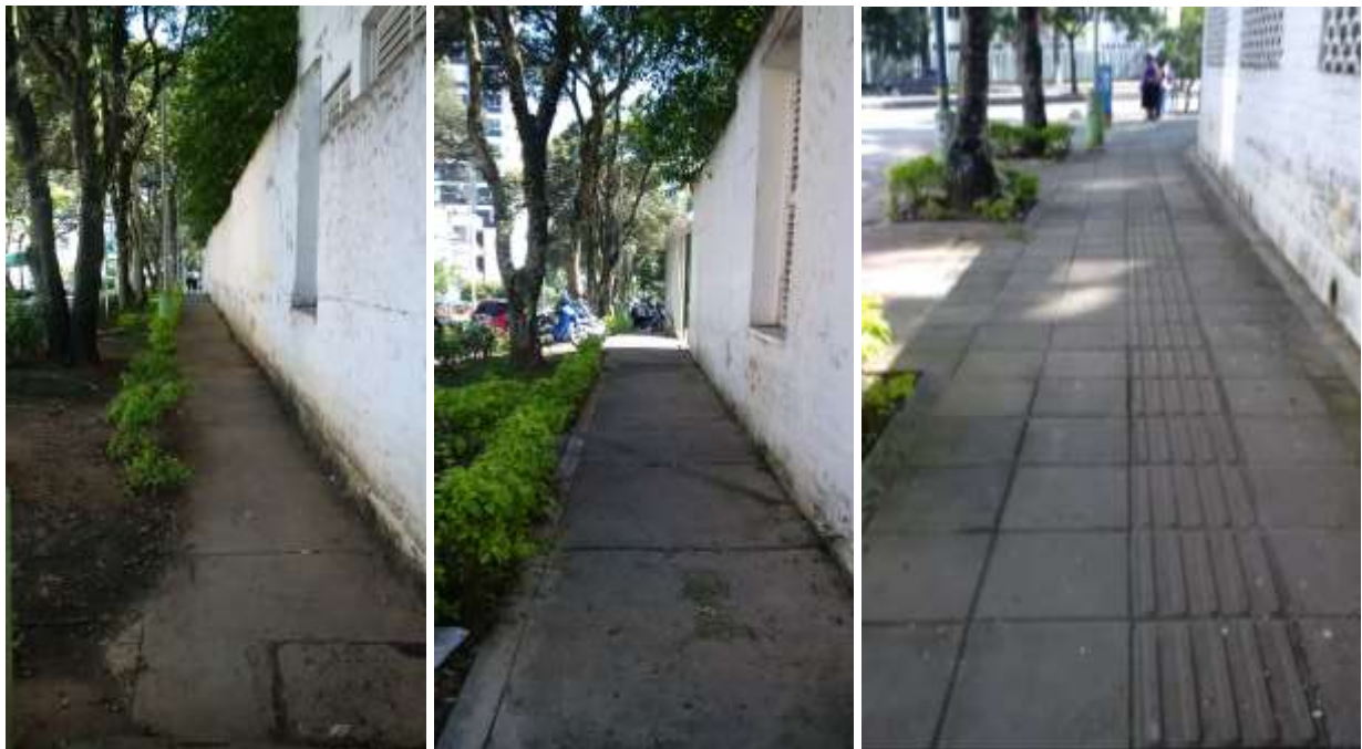
Figura 19. Tramo 7 estudiado del espacio público próximo al HUS en la Avenida Quebrada Seca con Carrera 32
