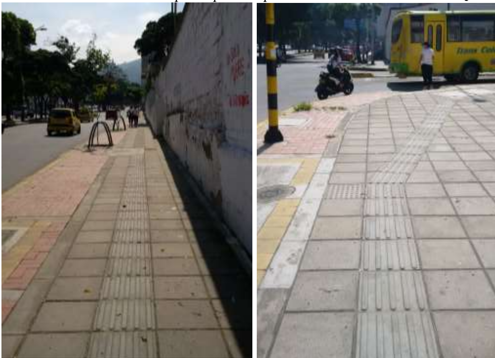
Figura 17. Tramo 6 estudiado del espacio público próximo al HUS en la Avenida Quebrada Seca
