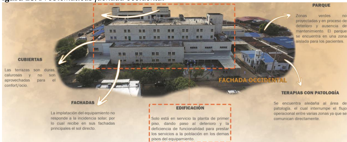
Figura 28. Problemáticas fachada occidental
