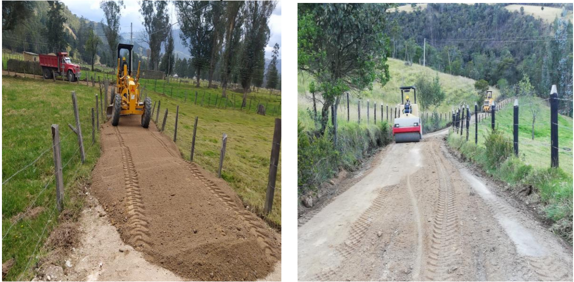
Figura 10. Reposición de material de afirmado
