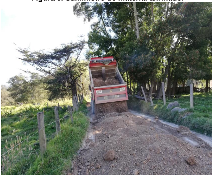
Figura 9. Suministro de material afirmado.
