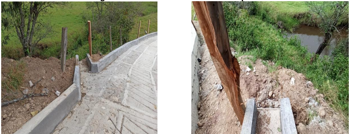
Figura 37. Construcción de un ciclópeo
