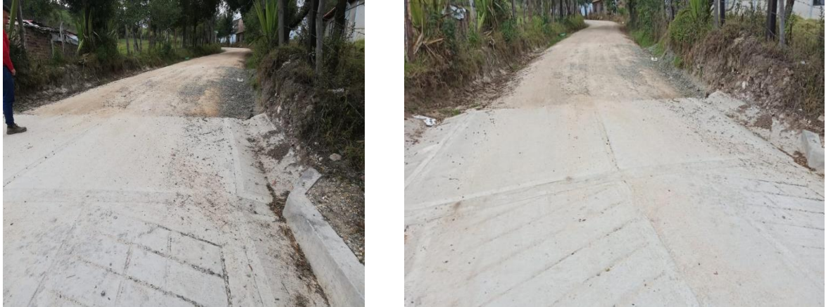
Figura 36. Acceso de placa huella sector Piscinas
