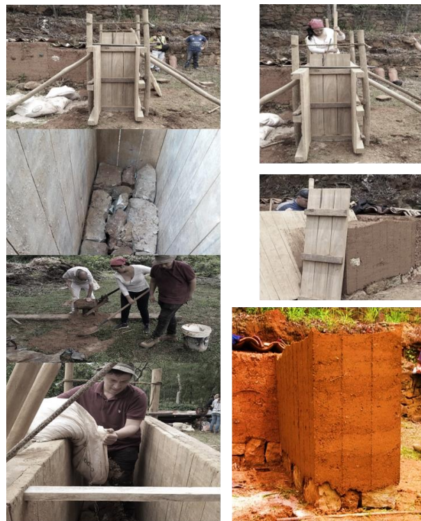
Figura 12. Proceso constructivo muro en tapia pisada.
