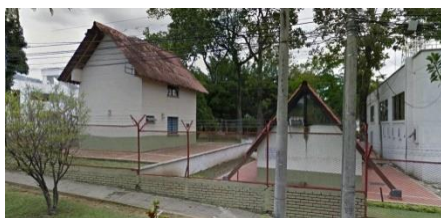
Figura 40. Edificios utilitarios Q.B.
