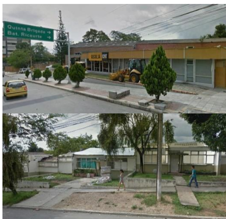
Figura 38. Casas fiscales Q.B. en demolición
