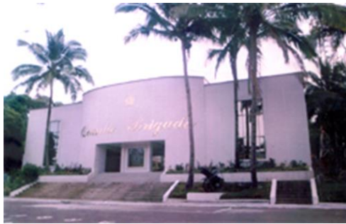
Figura 30. Edificaciones a conservar Auditorio
