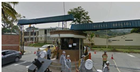
Figura 36. Edificios administrativos Q.B
